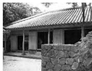
かわらぶ 瓦葺き屋根
