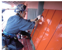
2006年から2010年にかけて、正殿外壁の漆再塗装が行われた様子
