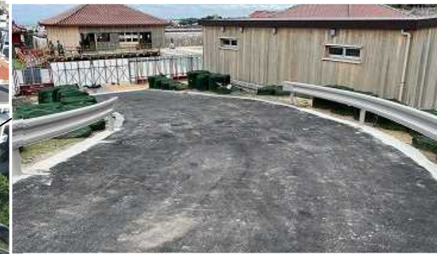
令和4年3月：工所用仮設道路（東側）設置
