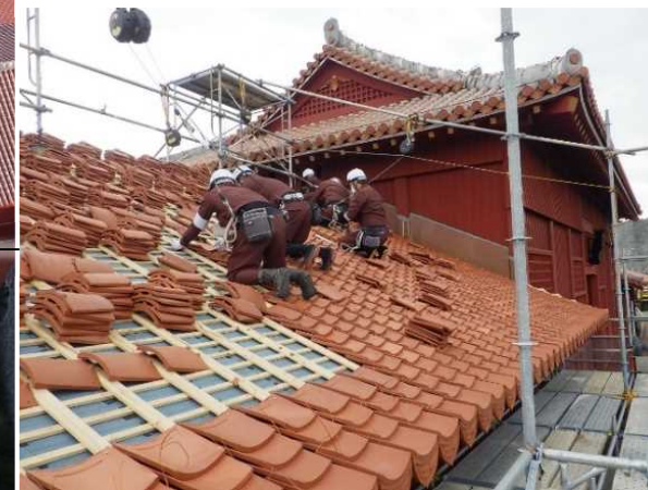
令和3年3月：奉神門応急復旧完了
