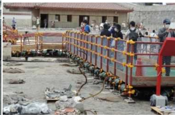
令和2年6月：見学デッキ設置
