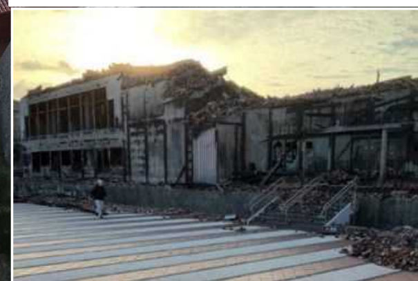
令和2年2月～：建物の撤去、瓦等の撤去
