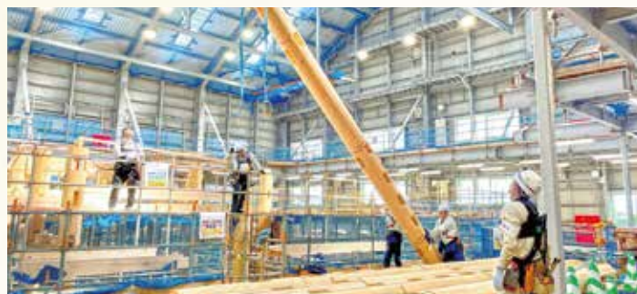
首里城正殿復元整備工事 建方工事(令和5年9月20日)
