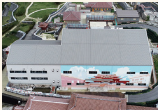
空から見た首里城復元現場の様子
