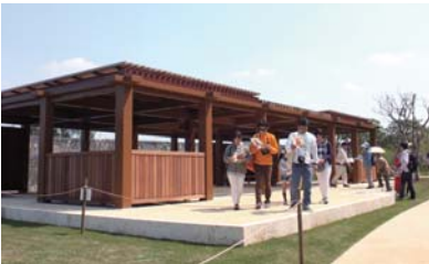
▲銭蔵の平面表示上に整備した休憩施設
