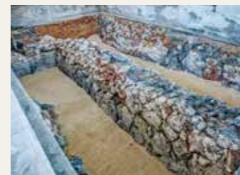
正殿基壇の石積み 第2基壇(右奥)と第3基壇(中央)
