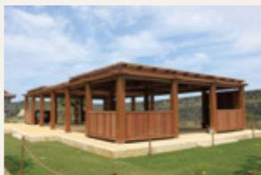
「銭蔵跡」の上に築かれたパーゴラ形式の休憩施設
