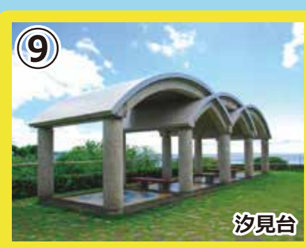
熱帯ドリームセンター裏あずま屋
