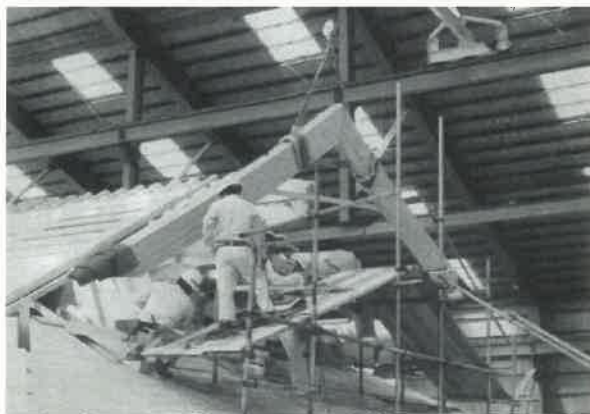
素屋根 (建築建物を覆う仮設屋根で天候影響をなくし工事を効率化)
