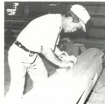
手ガンナによる丸柱の仕上げ
