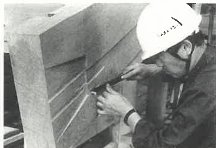
破風板の刻苧(注1)彫り
