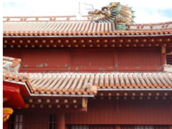
【外壁部 漆剝落】
