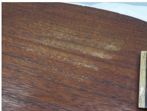
塗膜の劣化（腹板部分）
