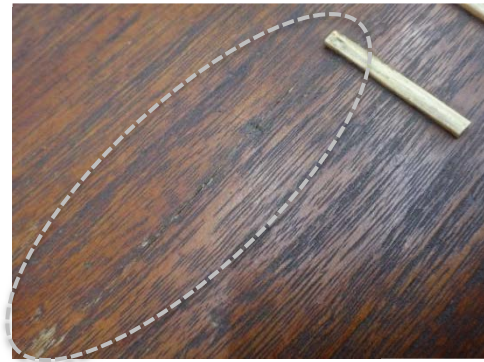
図4 腹板 木地亀裂
