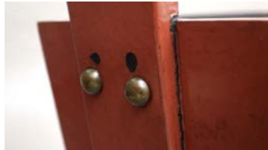
立上り竹釘部分 修理後
