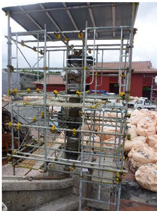
令和2年2月27日 大龍柱の補修が 始まる
