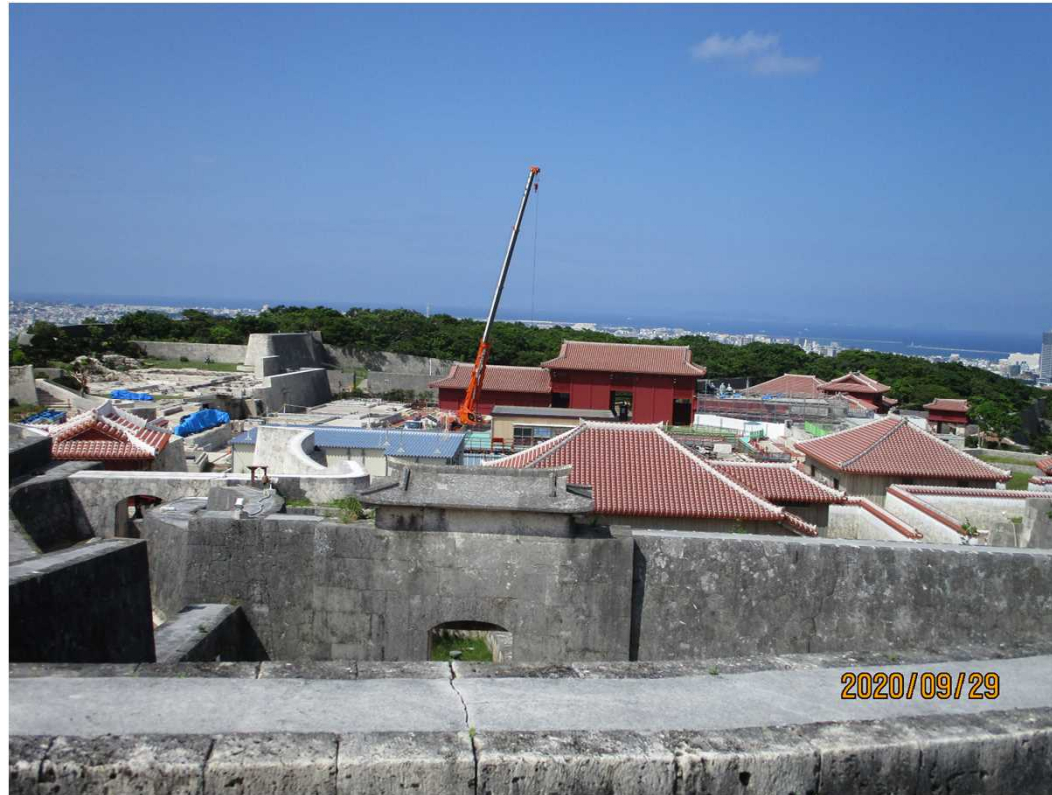
東のアザナより正殿方向を見る R2.9.29撮影
