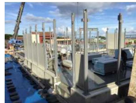
令和2年9月19日 仮施設設置作業
