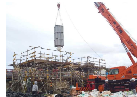
令和2年9月23日 大龍柱の取り外し作業
