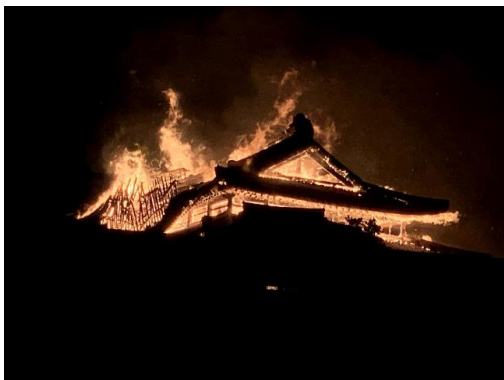
令和元年10月31日 首里城火災発生
