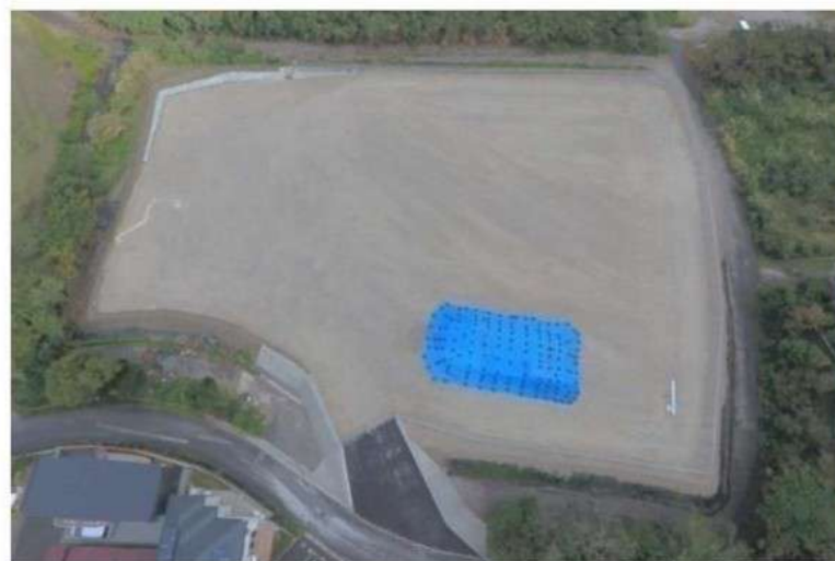
原土保管場所整備状況(R3.12末時点)
