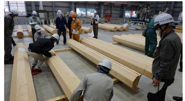
受け入れ検査の状況
