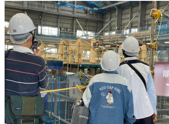
間近で組みあがる正殿の柱(2階)
