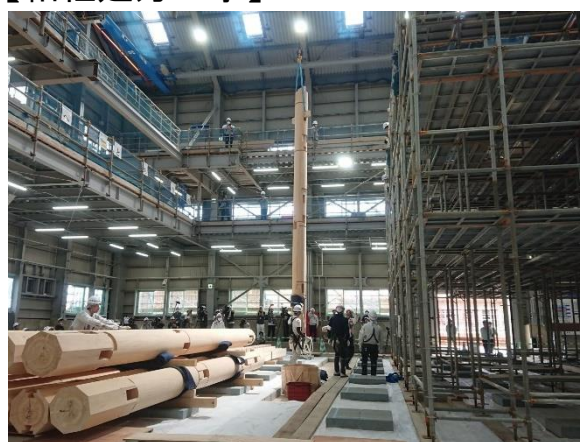
正殿の柱を吊る作業
