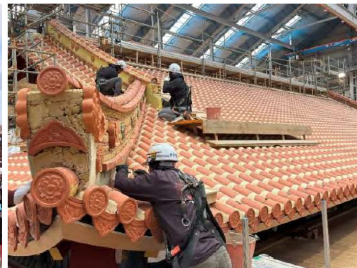
赤瓦、雲形飾瓦施工状況(R7.1.29)
