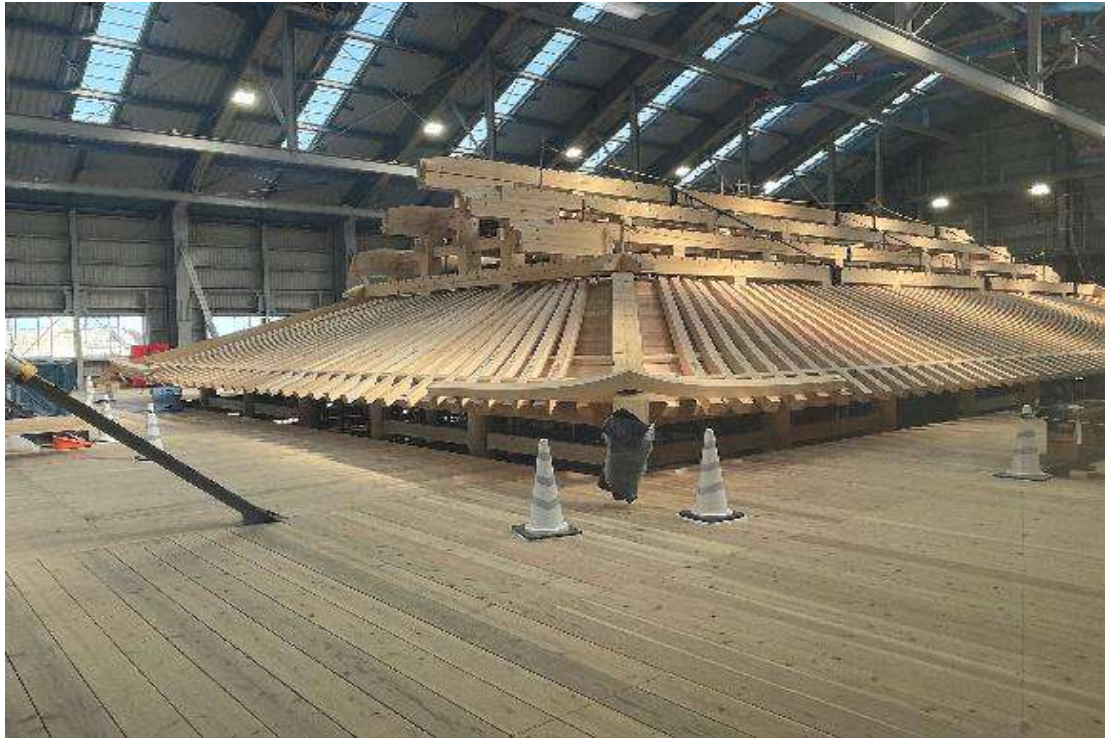
※首里城正殿屋根復元工事の様子
