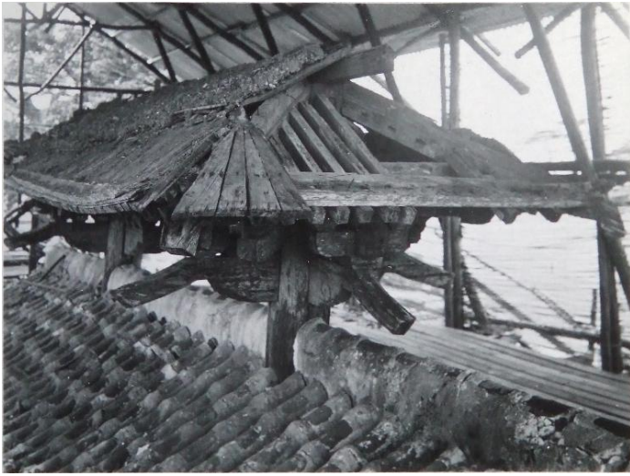
写真 10 解体中の上層屋根。
