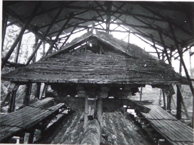
写真 12 解体修理中の上層屋根。竹と土で葺いている。
