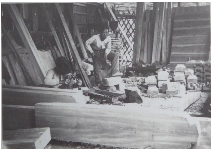
写真8 柱・料栱等の部材の加工風景。
