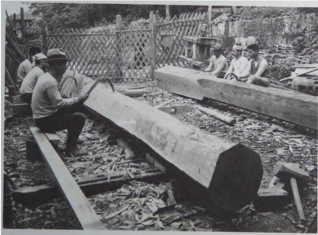
写真4 柱の鉋がけを行っている。
