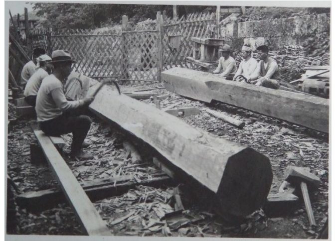
写真5 柱の鉋がけを行っている。
