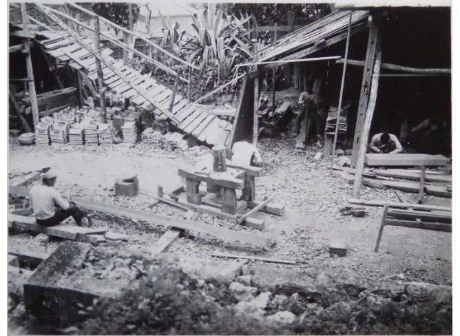
写真7 部材等の加工風景。
