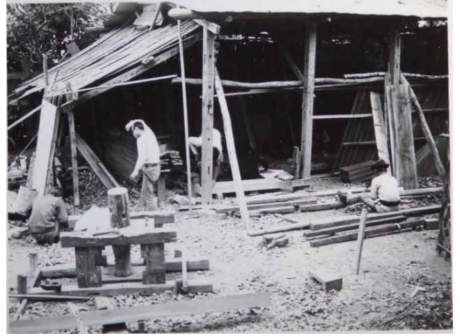
写真9 部材等の加工風景。
