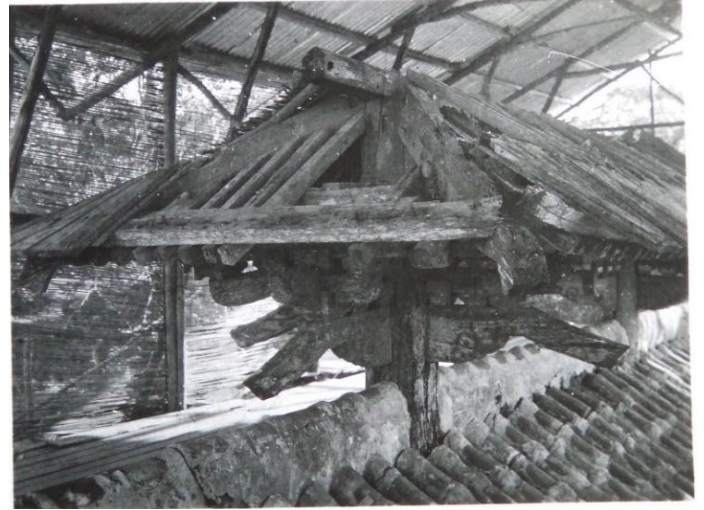
写真 11 解体中の上層屋根。
