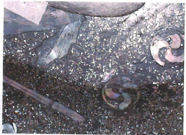
貝片の剥落箇所
