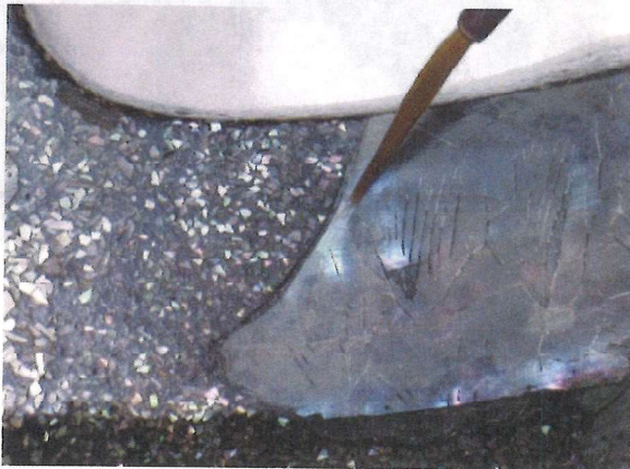
剥離螺鈿の養生
