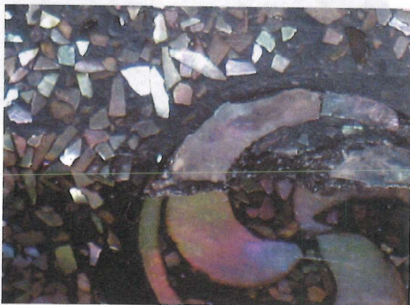
剥落箇所に貝片を合わせる
