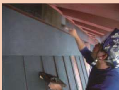
▲ 漆（うるし）塗装の下地として壁などに塗られます。
