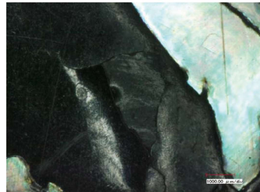
剥離・剥落箇所拡大
