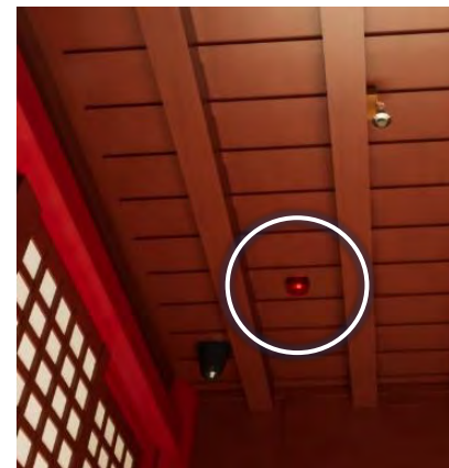
放火監視センサー設置イメージ
