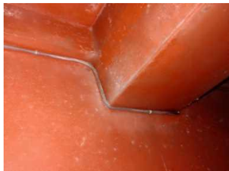
正殿内の熱感知器(空気管式)
