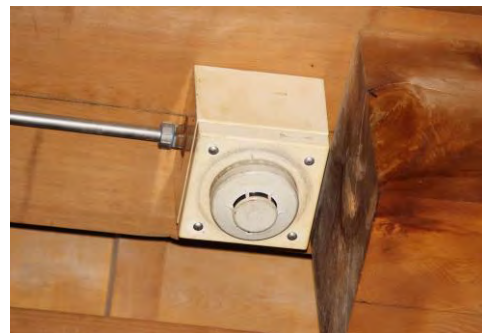
正殿内(3階)の煙感知器
