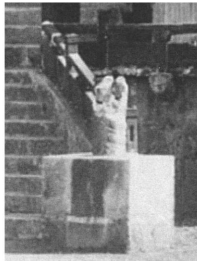
宮内庁古写真の損壊した龍柱基部
