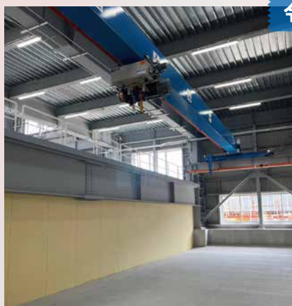
▲建物の1階。ここで加工した木材をクレーンを使って2階へと引き上げます。
