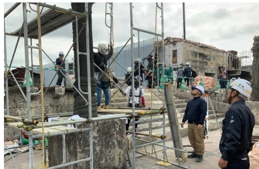
応急処置のための足場設置
