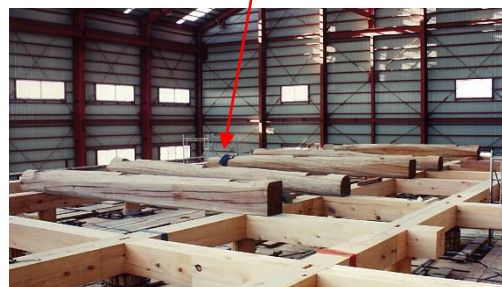
正殿 小屋丸太梁【前回復元時】 (オキナワウラジログシ)
