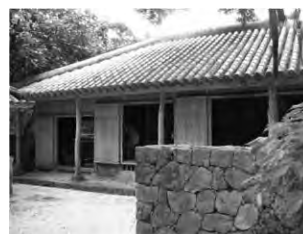
かわらぶ 瓦葺き屋根
