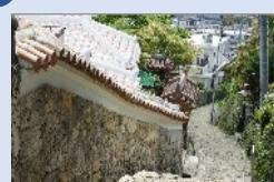
道路宽4m,全长约300m。由石头以敲打铺设的方式整理表面，再将20-30公分的琉球的石灰岩像马赛克一样铺设制成。
