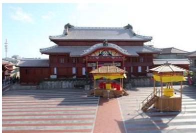
仮設物設置状況
