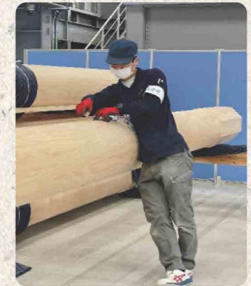
首里城正殿の木工現場
