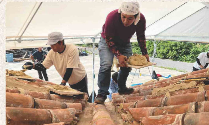
沖縄の建造物保存に関する技術伝承者養成事業「瓦葺き分野」研修
