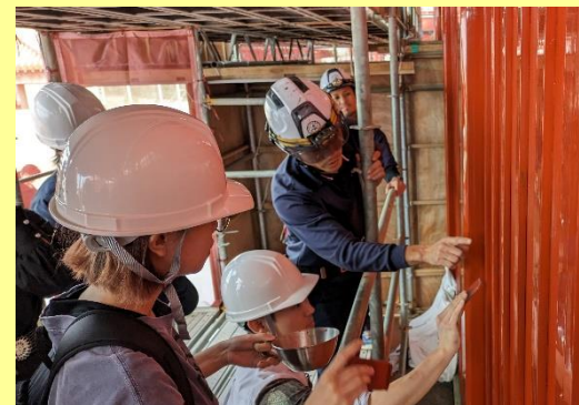
広福門現場での塗装作業体験
