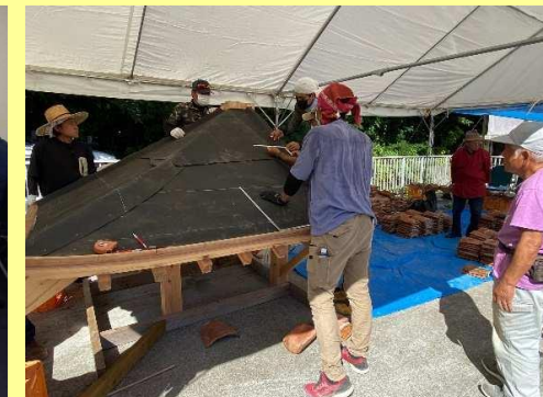
反りのある架台への割付と墨出し
