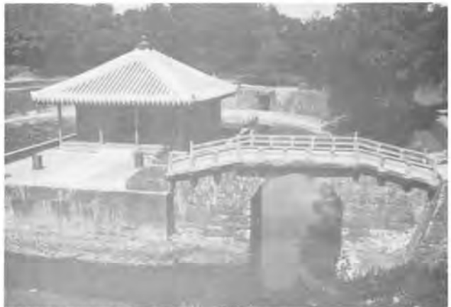
弁財天堂と天女橋 昭和43年、44年復元・修理
