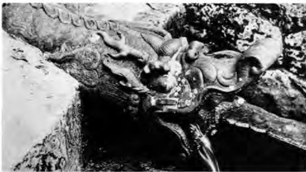
龍樋（『琉球建築』）
