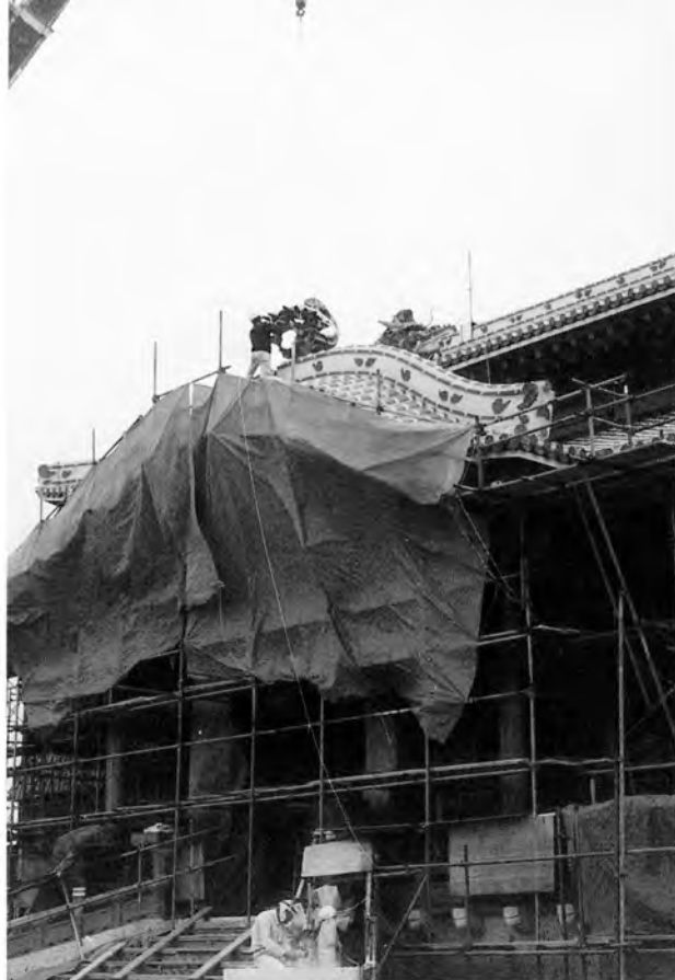
唐破風龍頭棟飾の取付
