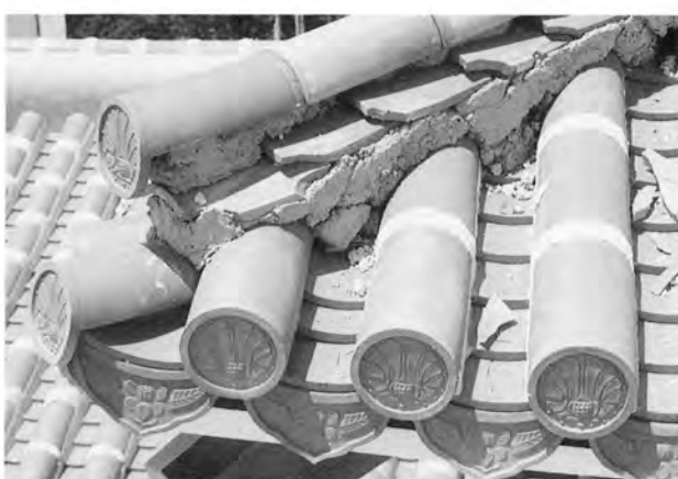
写真-6 丸瓦葺端部
