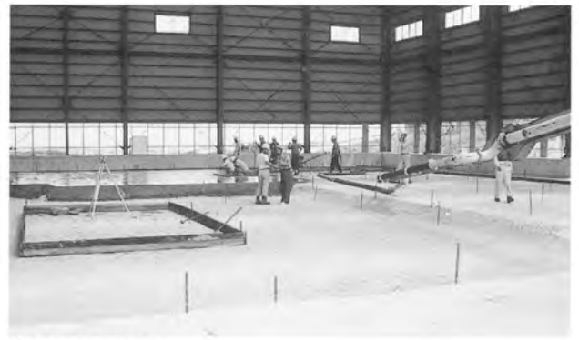
捨コンクリート打ち
