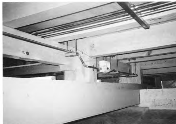
床下内配管状況
