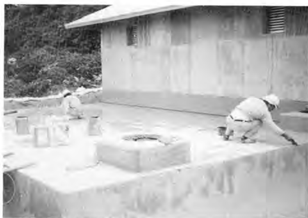
消火水槽天端の防水仕上
