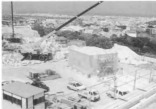
R C造躯体工事完了
