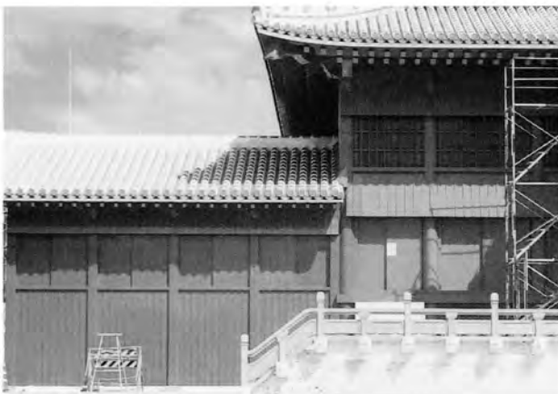
足場解体後の西之廊下
