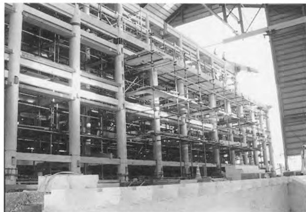
正面側の軸組 まだ唐破風部分は取付いていない
