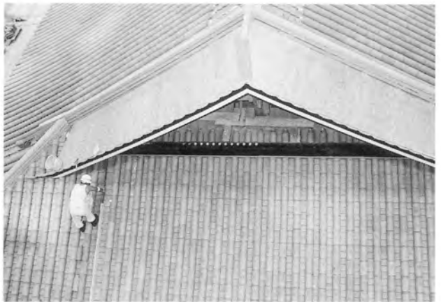
入母屋破風部分
