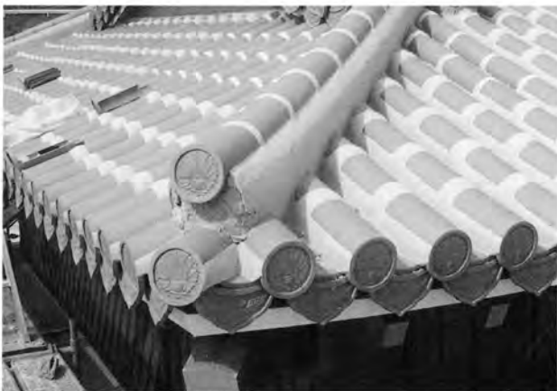
写真-7 漆喰包み、目地漆喰塗
