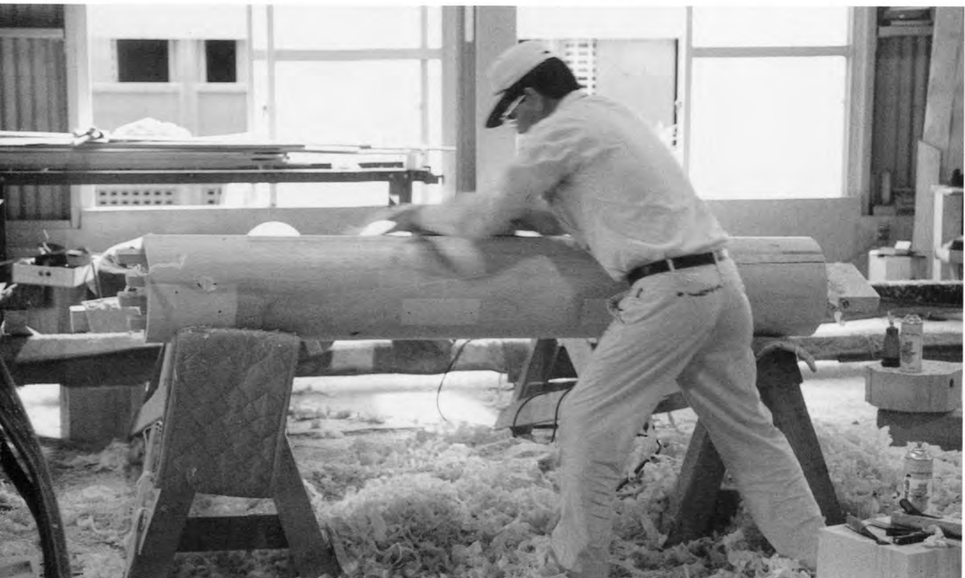
八角柱を丸柱へ加工
