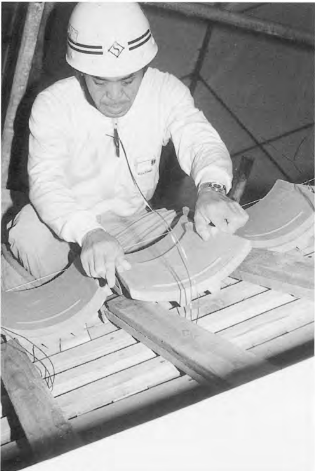
平瓦葺 横棧に引掛ける
