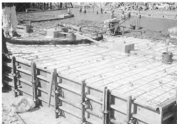
券売所側 土間コンクリート打ち
