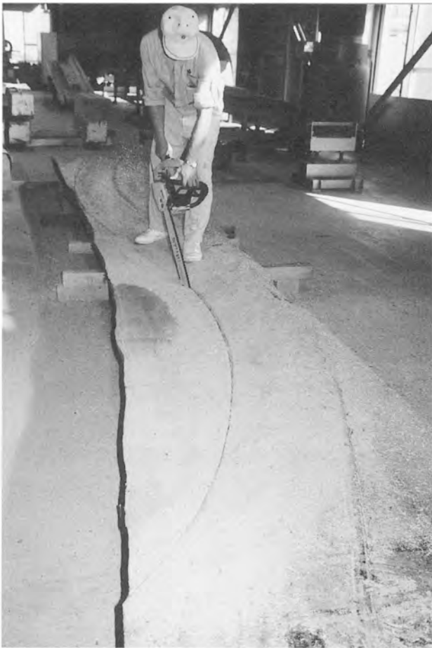
唐破風の破風板の加工
