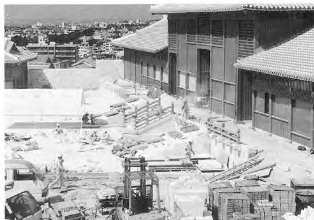
奉神門の石高欄取付工事
