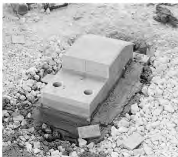
戸当り石据付
