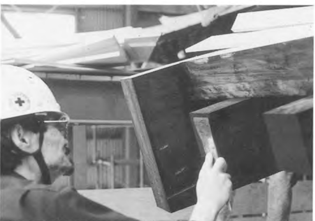
破風板小口の切粉下地付 木ベラで塗る
