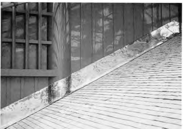
水切銅板取付
