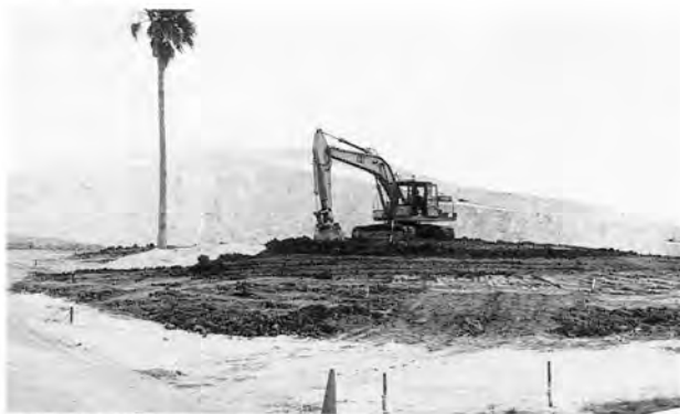
西のアザナ付近の客土敷均し
