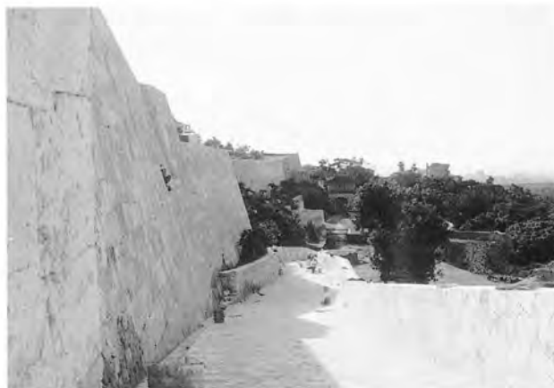
完成した礎道
