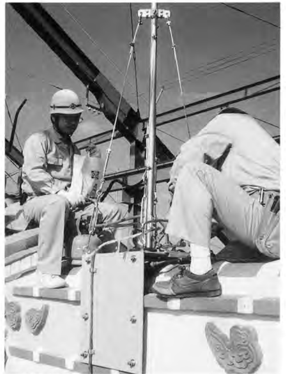
避雷針取付工事
