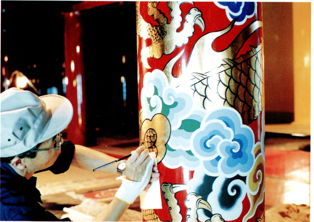
1階御差床柱の彩色 墨でくくりを入れる
