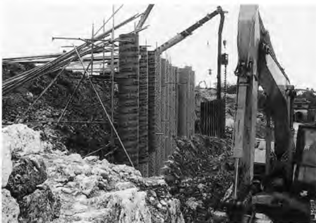
同上 円形ポイド型枠設置状況
