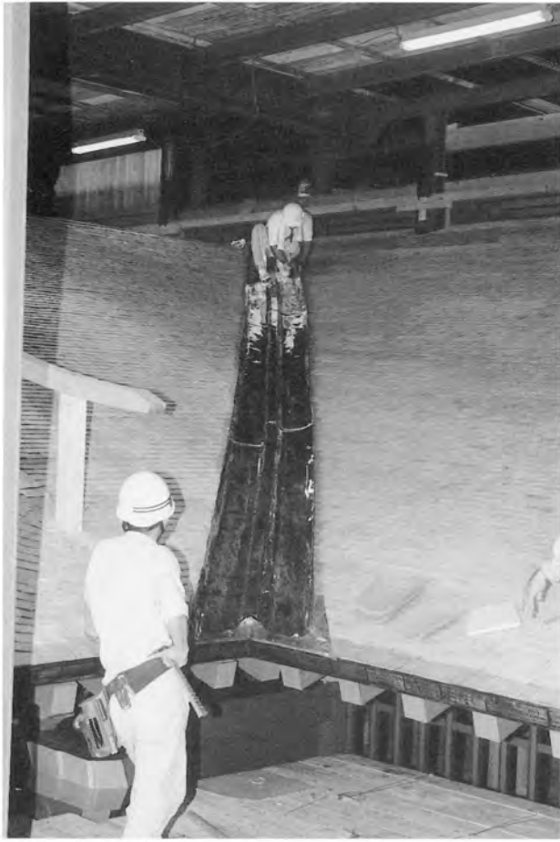
唐破風屋根の谷部分に銅板を敷く
