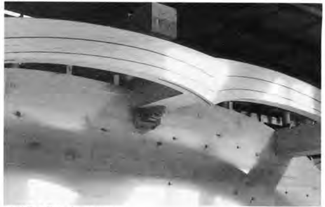
唐破風の見上げ（建方中）
