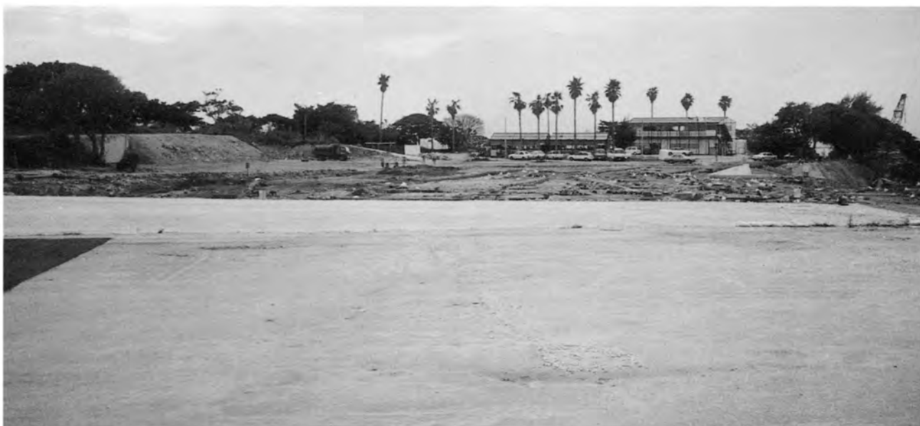
正殿建設予定地より西側を見る
