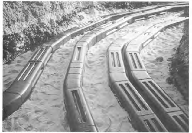
孔陶管敷設状況
