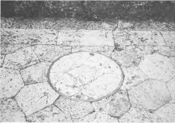
北殿北側城壁の器具（昼間の状態）
