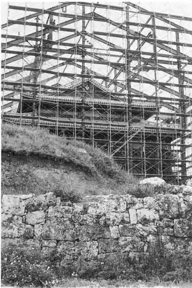
素屋根の解体 手前は石積遺構
