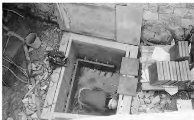
溜桝の石貼り工事
