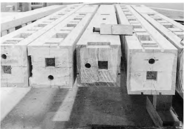
柱底部の加工
