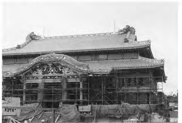
素屋根鉄骨解体完了 (1992年3月28日)
