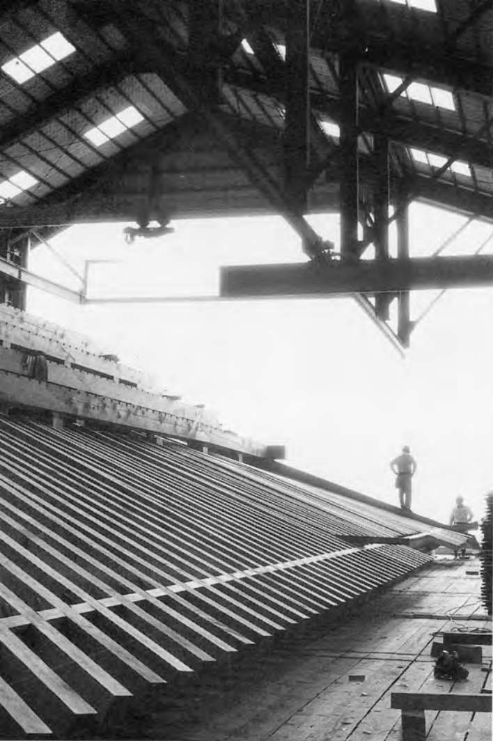
上層屋根飛檐垂木
