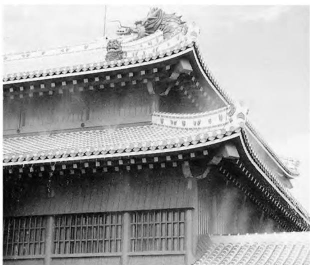
ドレンチャーの放水
