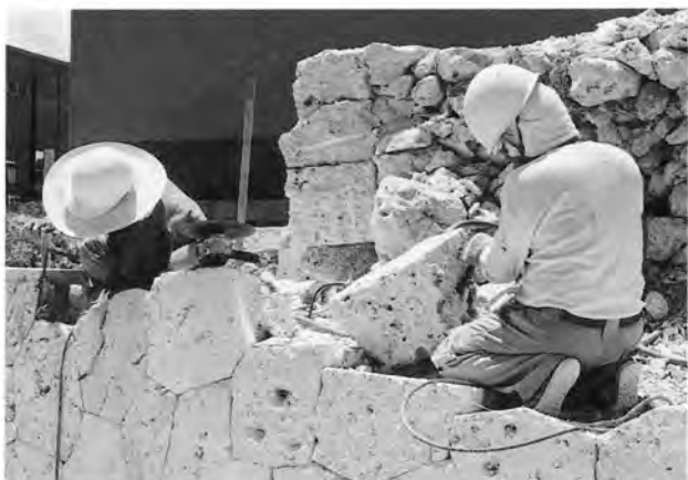
石積 合端が密着するよう正確に加工した
