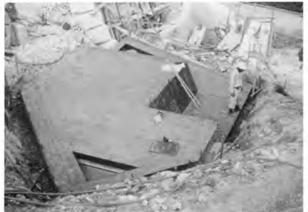
H型鋼敷設状況
