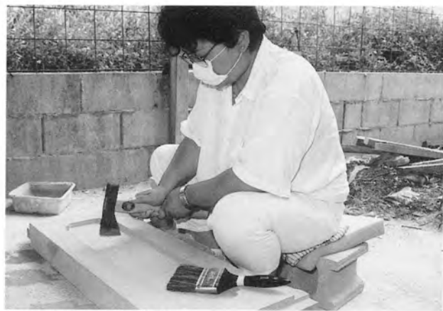
石高欄の羽目石 斧叩き仕上
