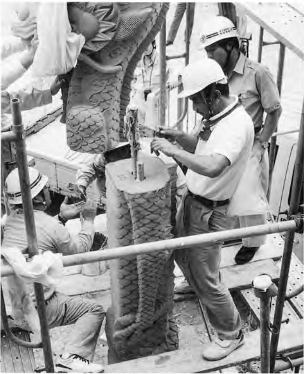
同上 ステンレス棒に接着剤を塗る
