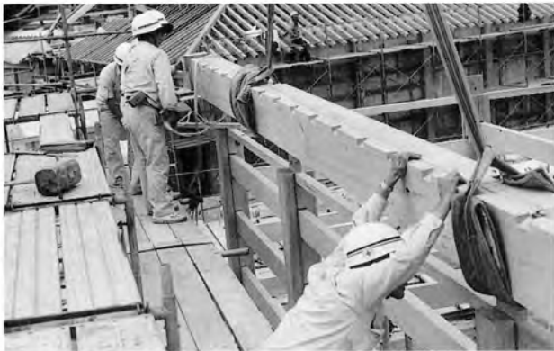
建方 軒桁取付
