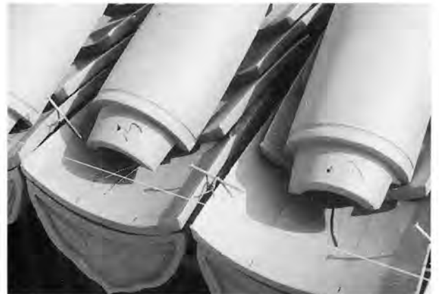
ホルマル軟銅線に釘を掛けて軒先瓦、二の平瓦を固定
