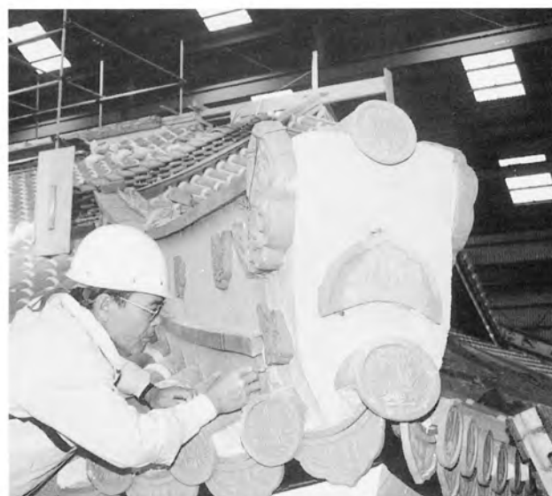
棟積先端の漆喰仕上
