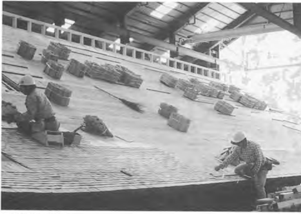
上層屋根柿板葺
