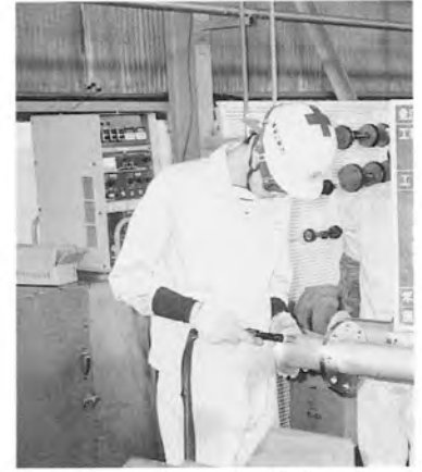
ステンレス管工場加工状況(仮付)
