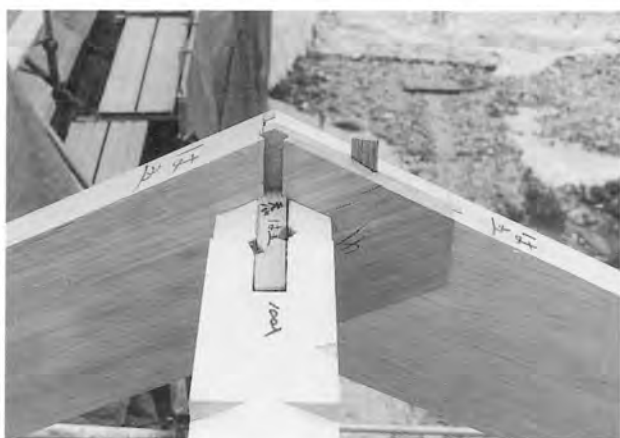
棟木と破風板の納まり
