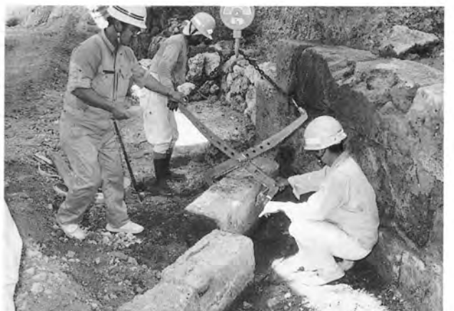
同左 取外し状況
