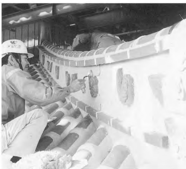
棟積漆喰仕上
