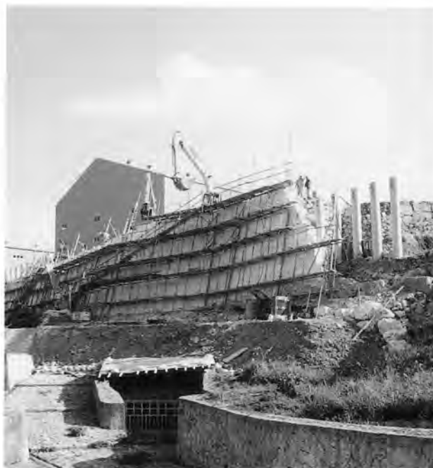
抑止杭設置後の石積工事
