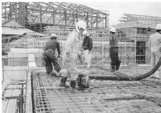
便所側 躯体コンクリート打ち
