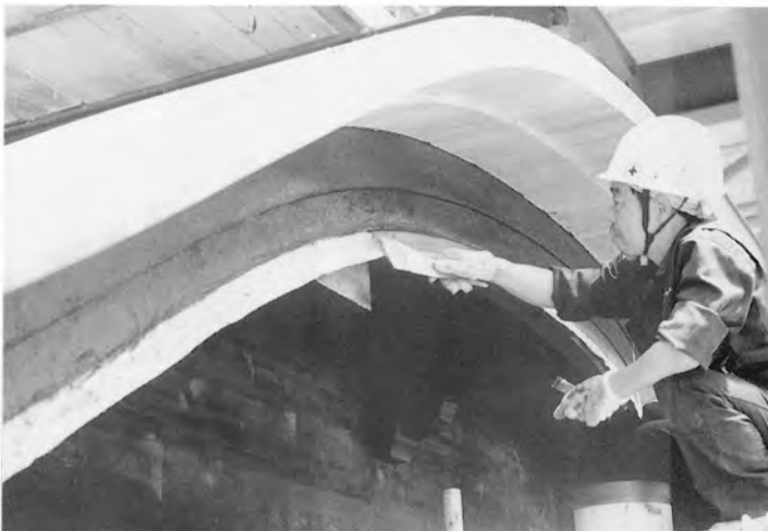
破風板の布着 曲線にそって漆で麻布を貼っていく
