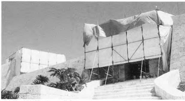
瑞泉門、漏刻門 シート養生
