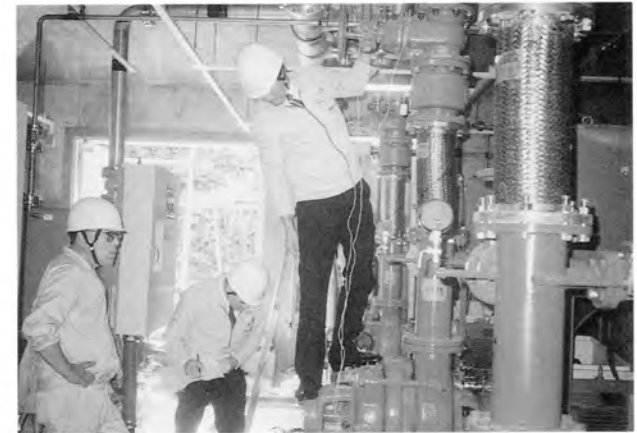
ポンプ室内ステンレス管絶縁測定状況
