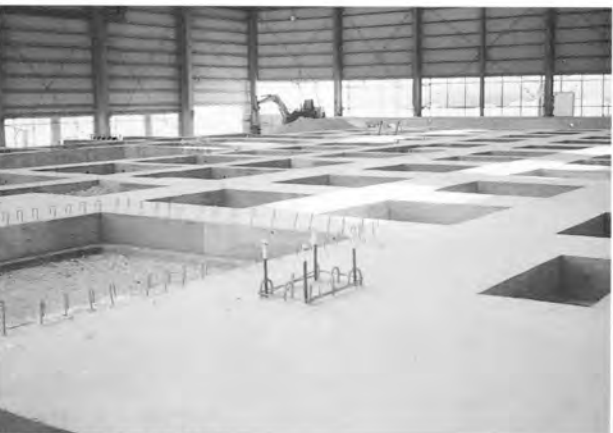
型枠をはずした基礎の状況
