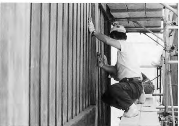
壁の漆下塗作業
