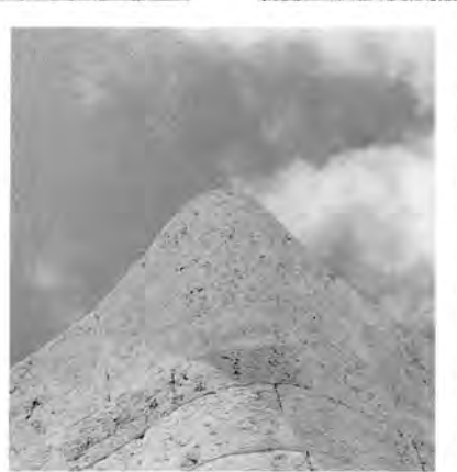
隅頭石の見上げ
