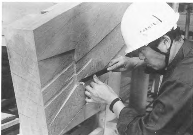
破風板の刻苧彫り
