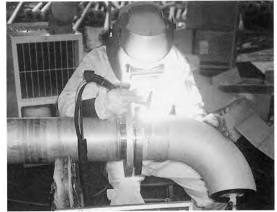
ステンレス管工場加工状況(手溶接)
