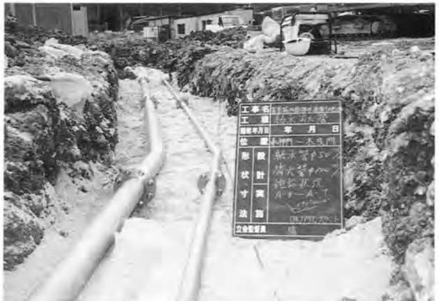
屋外埋設配管設置状況
