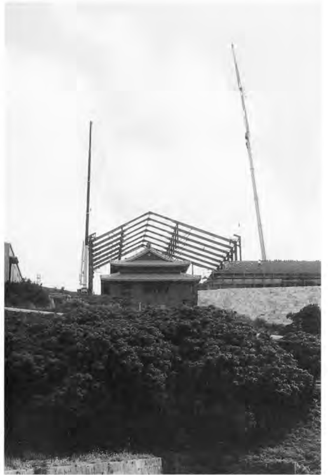
素屋根の解体
