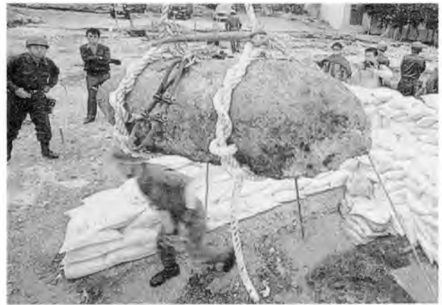
同左 撤去作業 (昭和61年11月28日)
