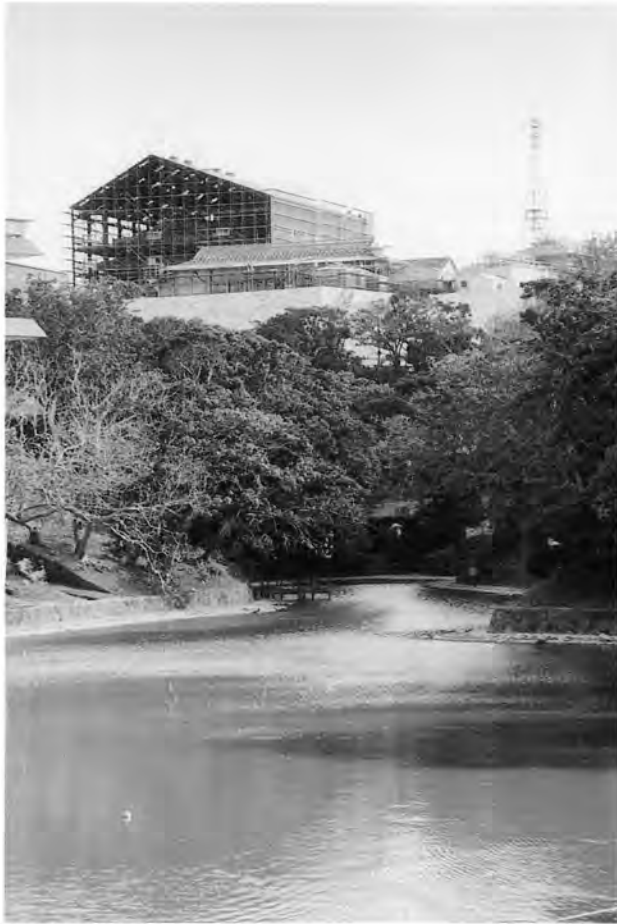
龍潭越しに素屋根を見る
