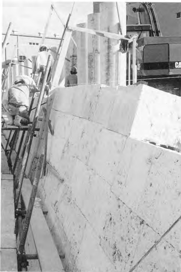
石積（布積） 丁張、水糸に合わせて石積を行った。
