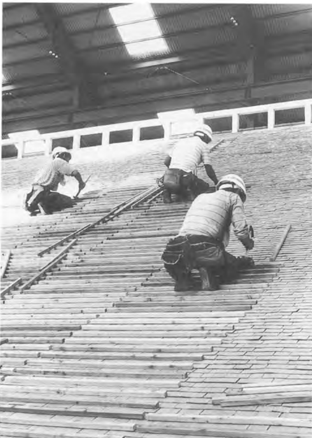
屋根下地材取付
