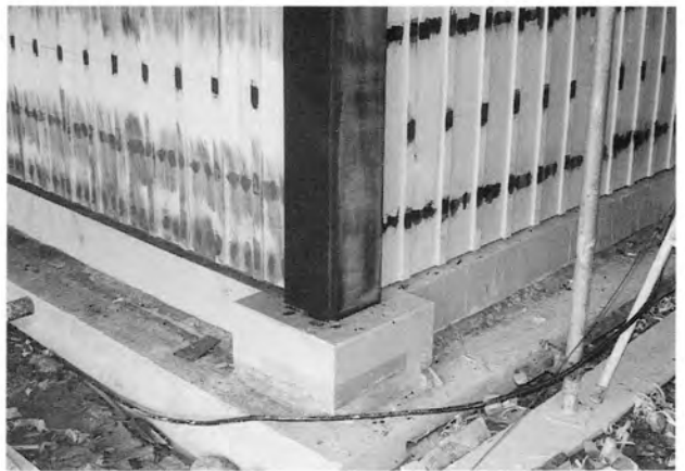
柱、外壁 塗装下地
