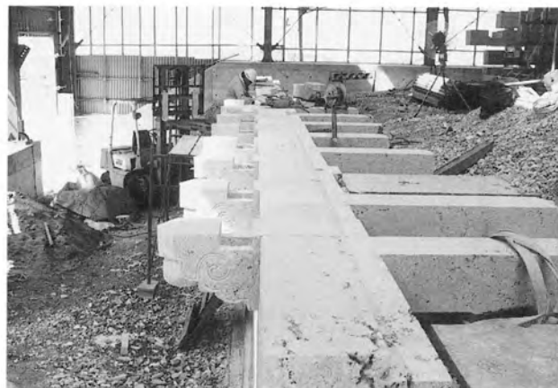
正面基壇の持送り石据付
