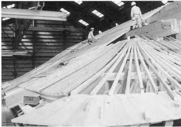
上層屋根の野垂木、切裏甲取付
