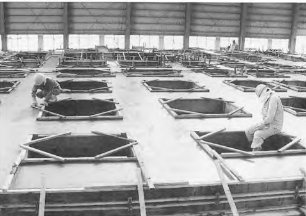
基礎のコンクリート打ち
