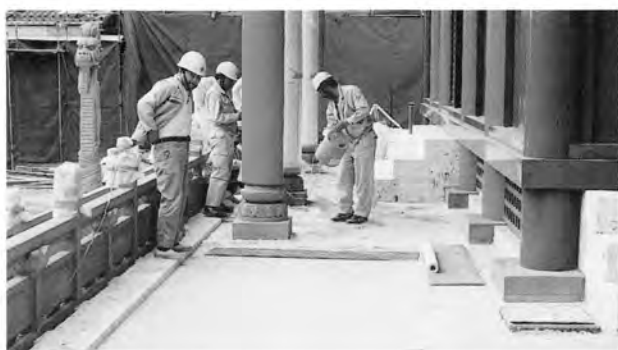
基壇の土壌処理
