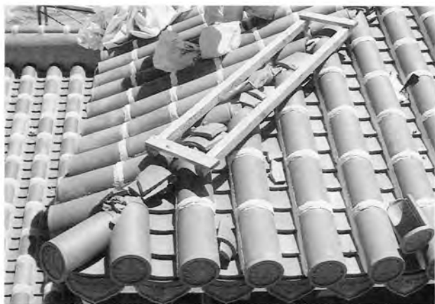
写真-1 瓦を砕いたものを敷き並べる
