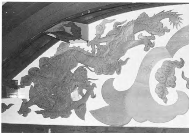
唐破風妻飾彫刻の取付状況
