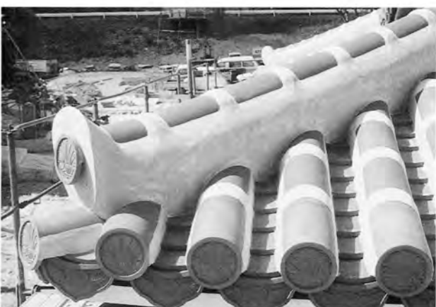
写真-8 隅棟端部 漆喰で逆卵形に仕上げる
