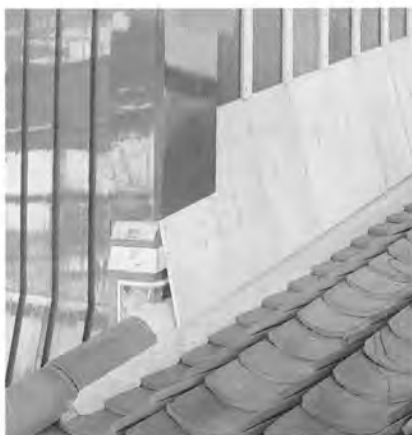
雨仕舞 銅板敷の上霧除取付
