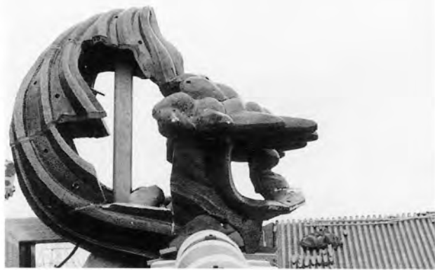
唐破風龍頭棟飾の取付
