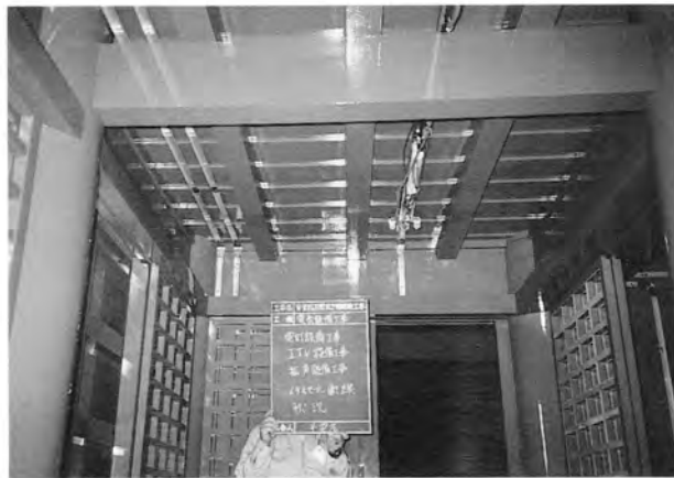
金属線び取付
