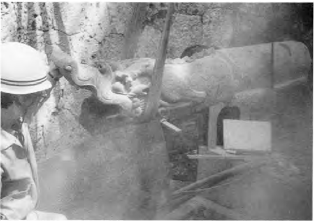
往時あった場所への設置作業
