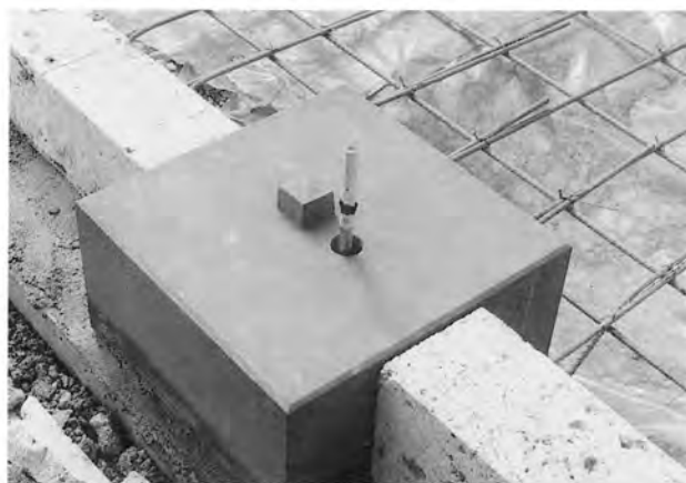
礎石とアンカーボルト
