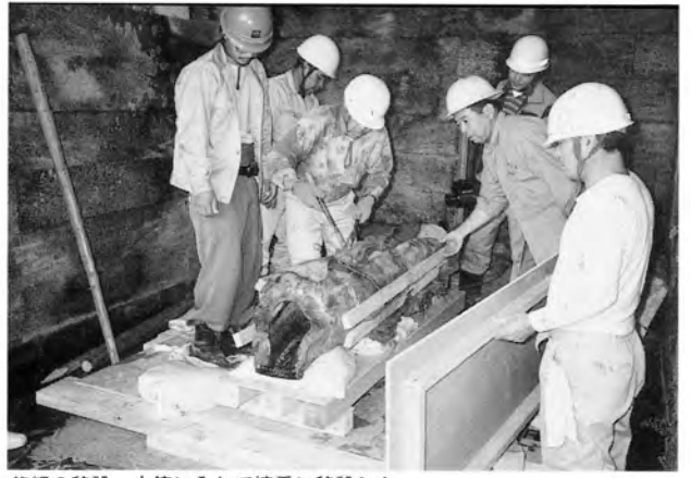
龍樋の移設 木箱に入れて慎重に移設した
