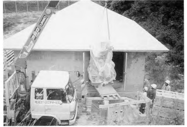
消火ポンプ搬入状況
