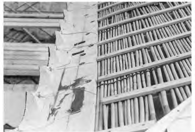
軒先廻り 瓦座にホルマル軟銅線を釘止め
