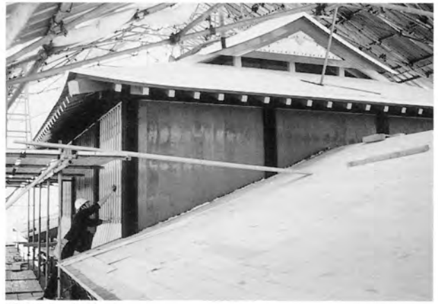
外壁塗装 下塗
