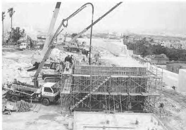
便所側 躯体コンクリート打設
