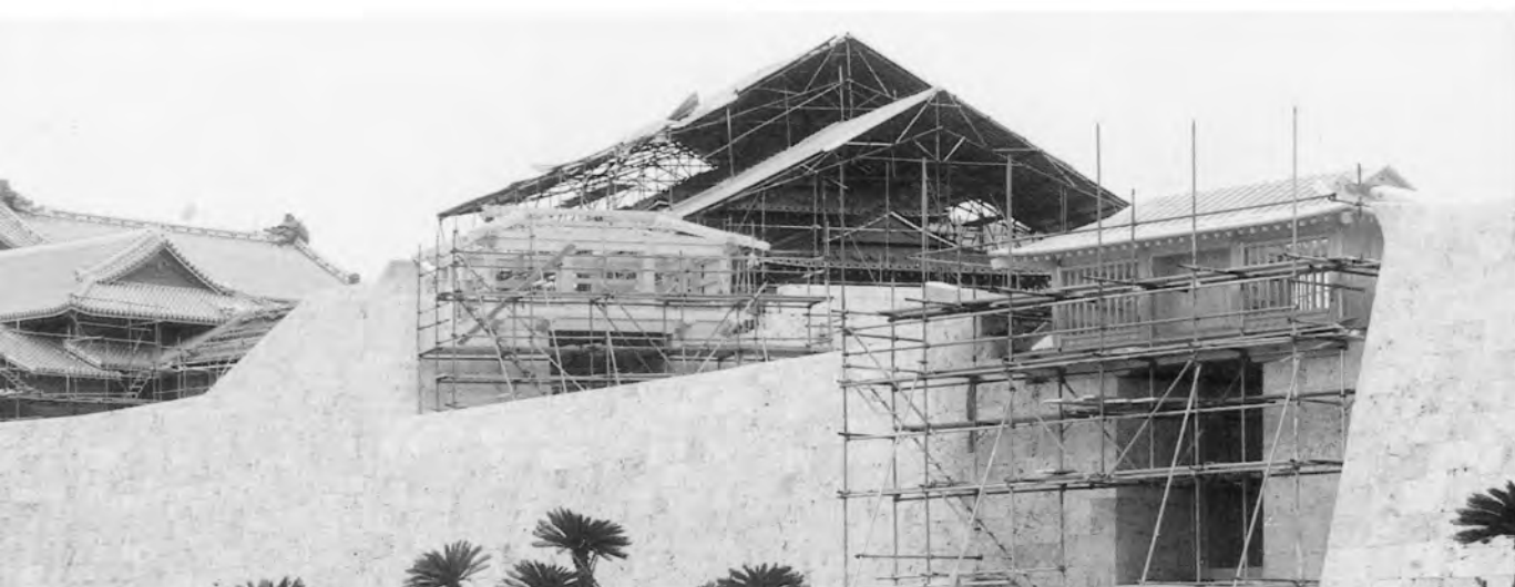
瑞泉門、漏刻門
