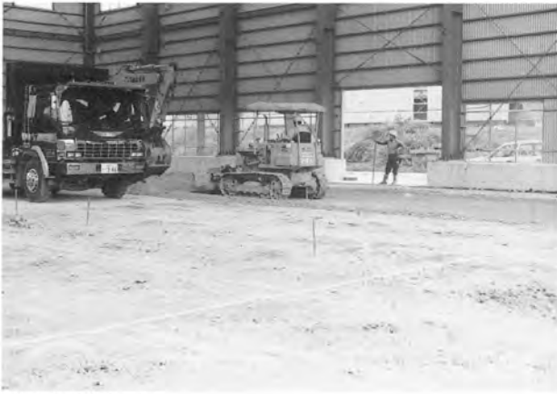
素屋根内の根切工事
