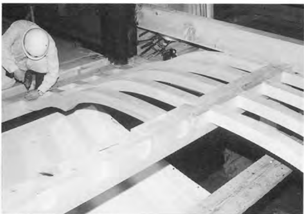
1階御差床天井の次垂木取付
