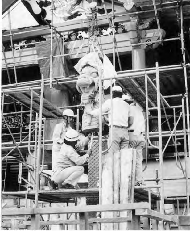
大龍柱の据付
