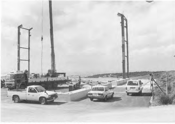
素屋根鉄骨建方開始 (1990年3月26日)
