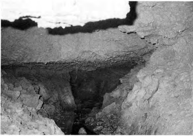
龍樋の奥の地下空洞 突き当たりから湧水が流れている
