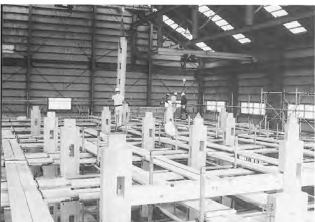
上層柱の建方 天井走行クレーンで吊り上げる
