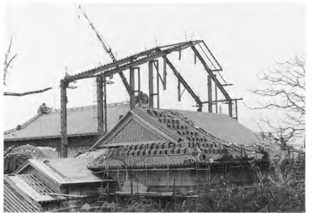
素屋根の解体
