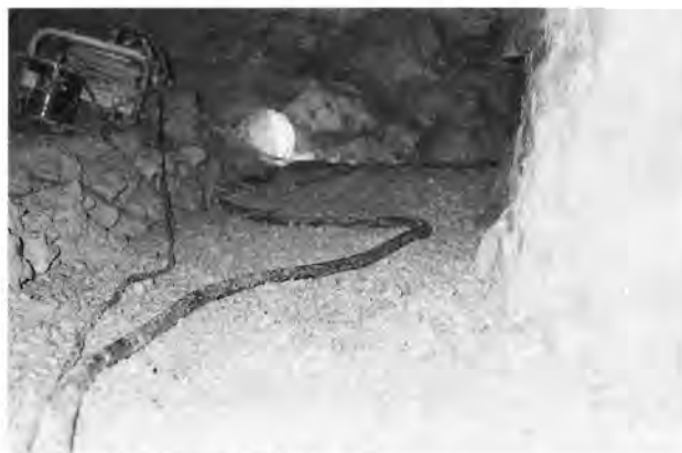
空洞内にクラッシャーランを敷いた状態
