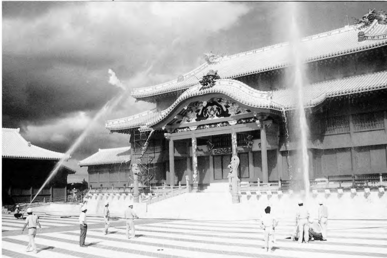
防災設備試験 御庭の放水銃
