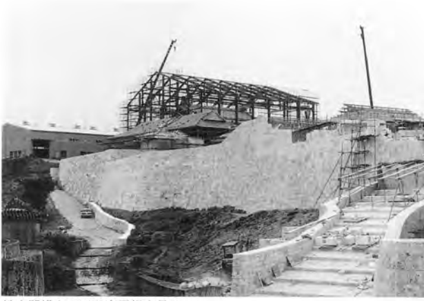
歓会門横から正殿素屋根を見る
