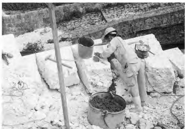
合端に裏込モルタルを詰めた
