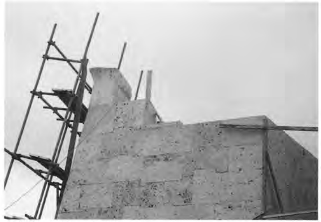
漏刻門石積 隅頭石の取付
