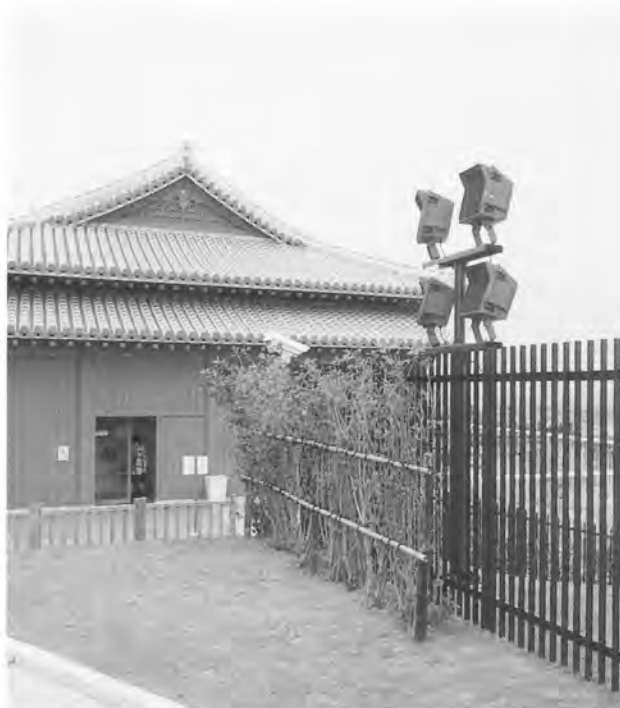
ポール型ライトアップ器具 (正殿北側)
