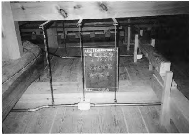
天井内電気配管状況
