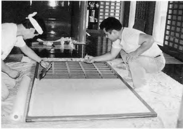
建具工事 障子紙の貼付
