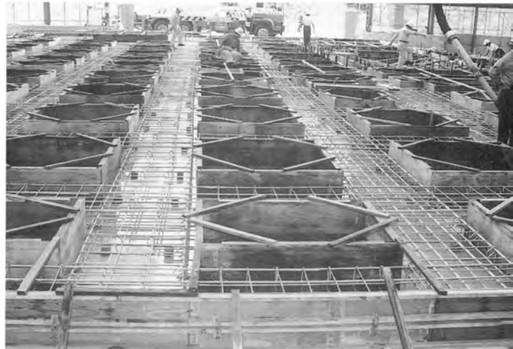
布基礎の配筋
