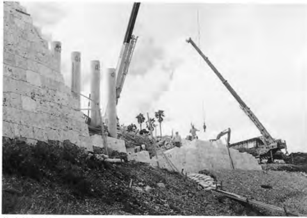
抑止杭打設工事
