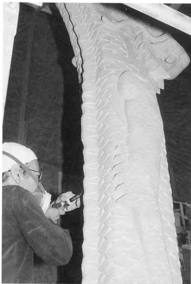
大龍柱の彫刻 鱗の1枚1枚を仕上げる
