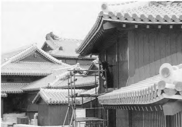
扁額取付 奥は北殿、正殿
