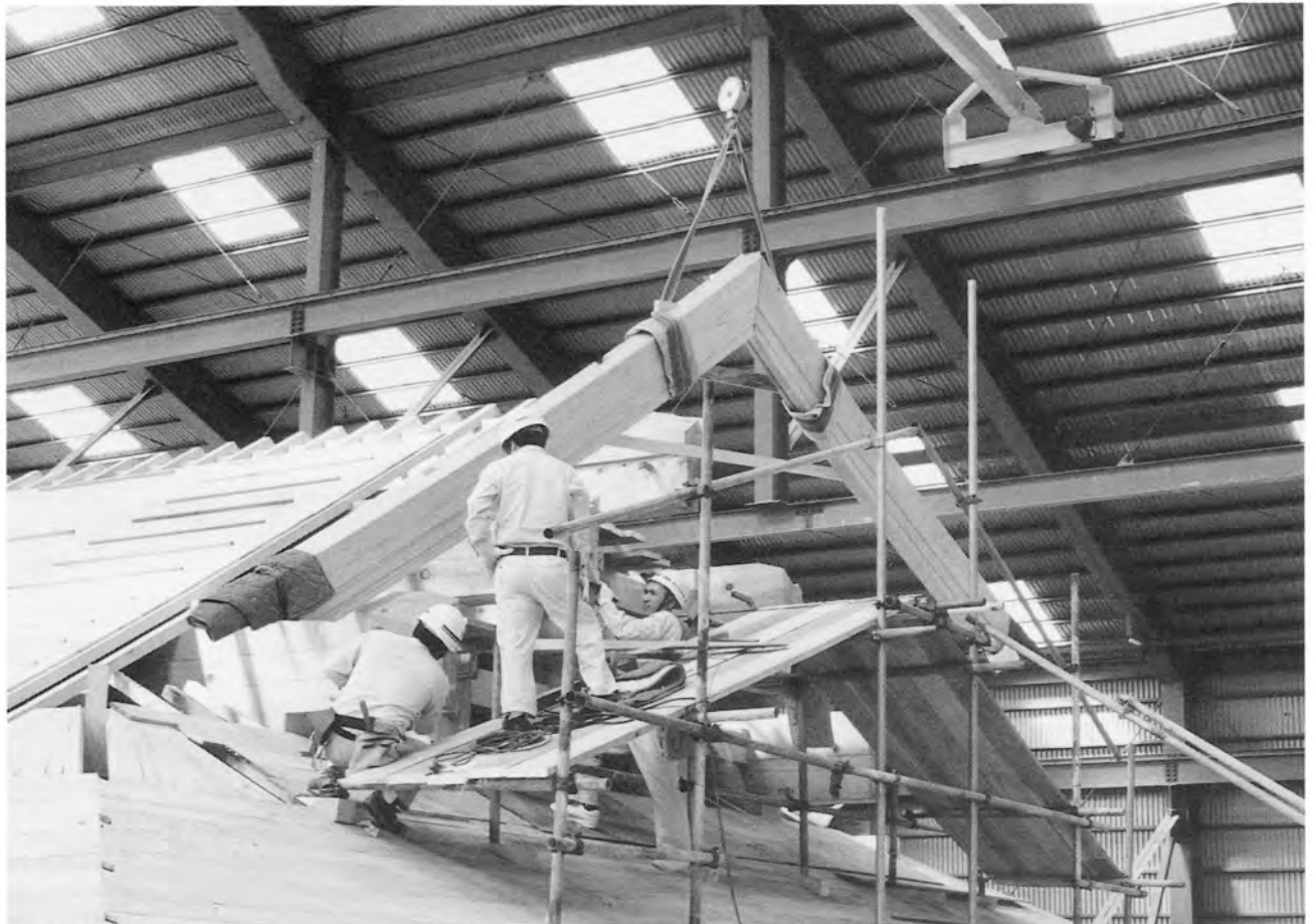
入母屋破風の取付
