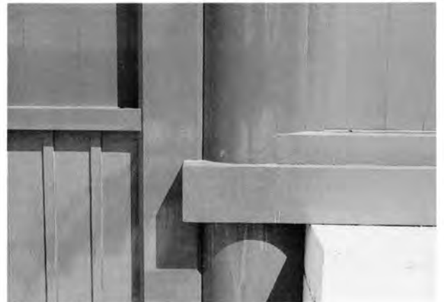
正殿との取付
