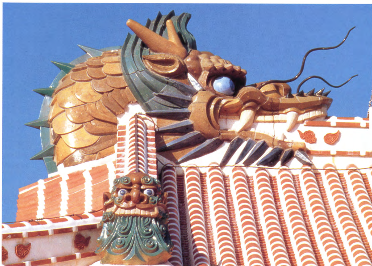
正殿大棟の龍頭棟飾（北側）
