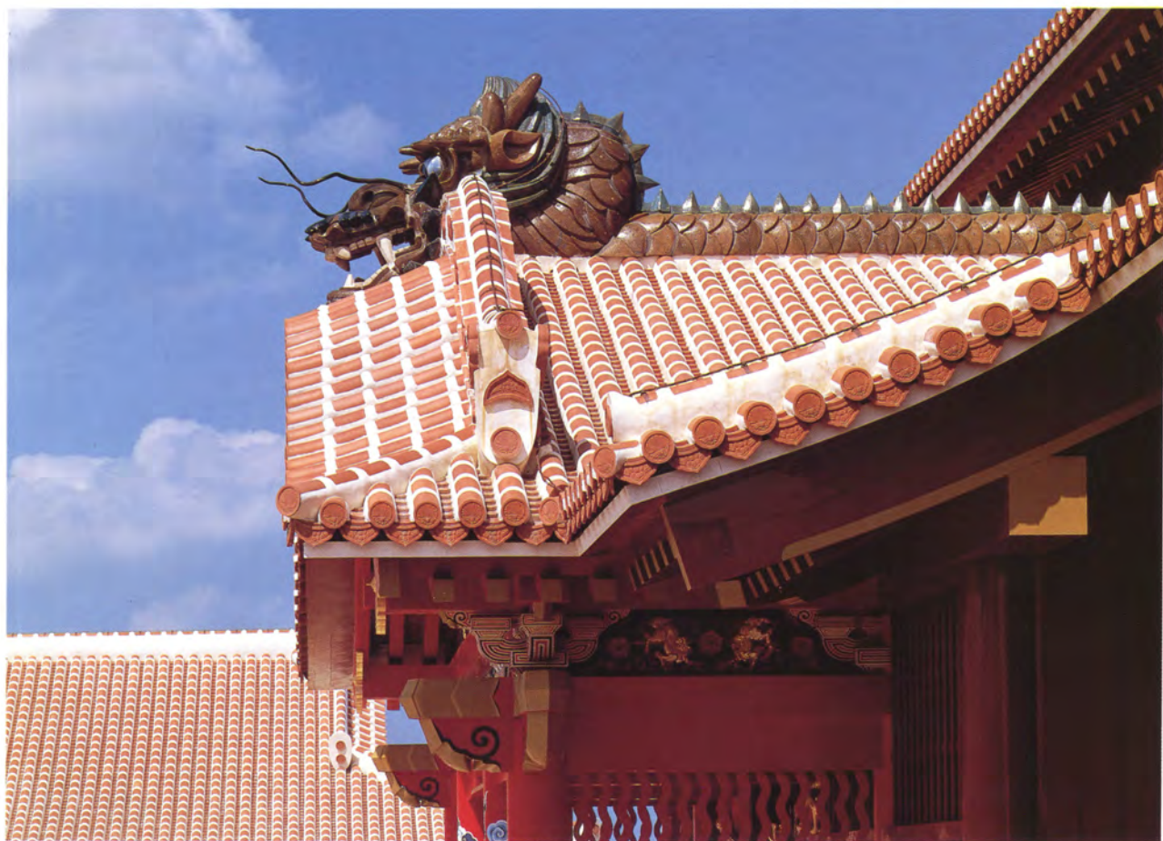
正殿唐破風の龍頭棟飾を側面より見る。釉薬の施された焼物で製作している
