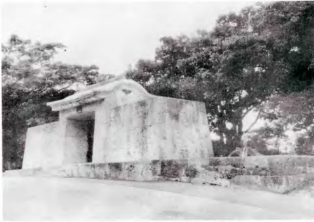
園比屋武御嶽石門 昭和32年復元修理、昭和61年保存修理
