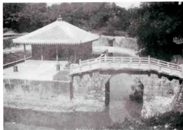
弁財天堂と天女橋 昭和43年、44年復元・修理
