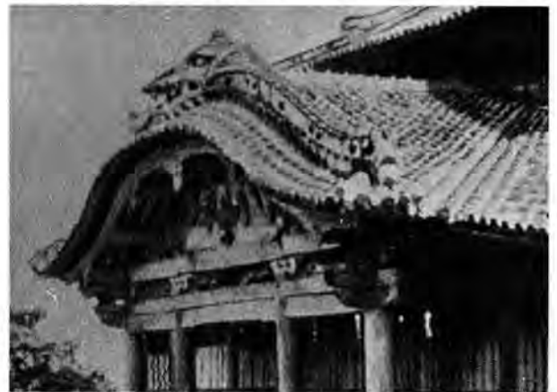
写真-2 棟の後方部分
