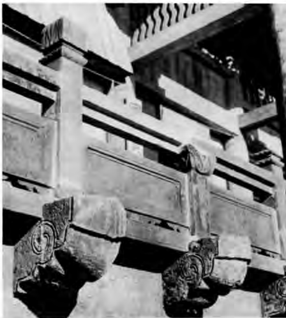
写真-1 石高欄「琉球建築」
