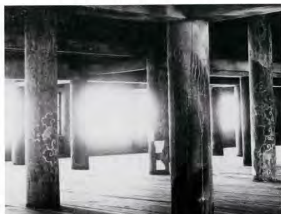
写真-2 同上、2階御差床柱
