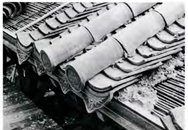
写真-1 土葺工法の事例（弁財天堂）
