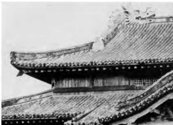
写真-1 上層屋根の軒先 文化庁文化財保護部建造物課蔵
