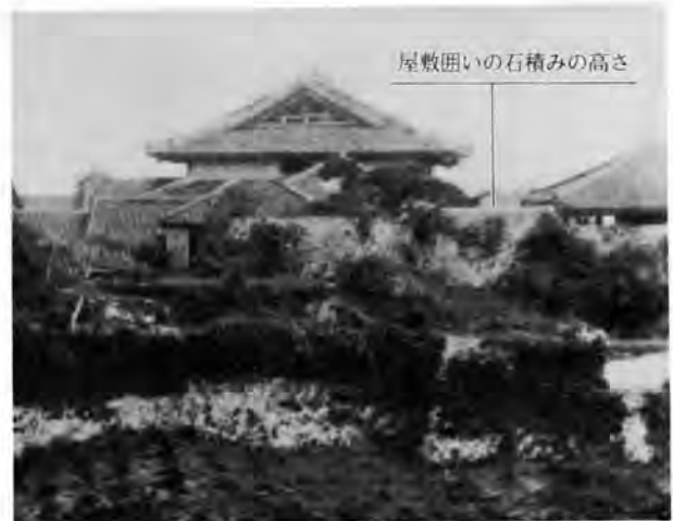
写真-1 首里城の南側から見た石積
