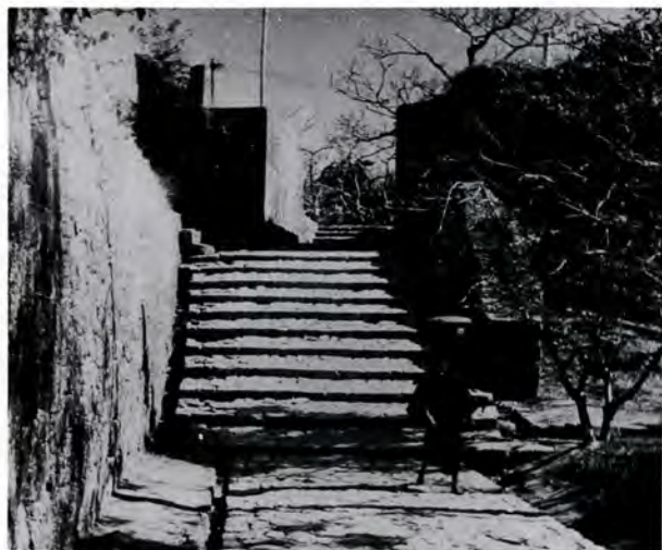
写真-1 漏刻門礎道 坂本万七写真研究所蔵
