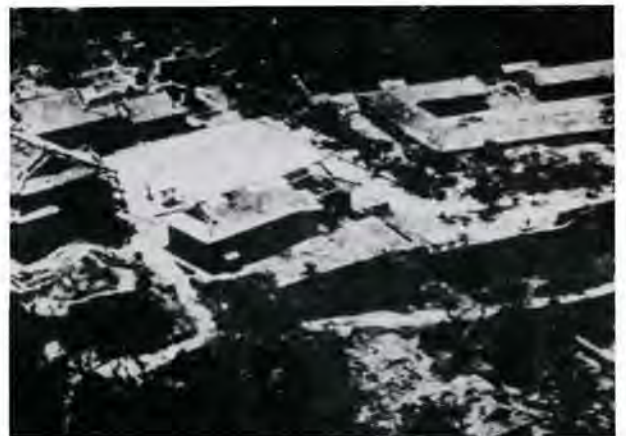
写真-1 破壊される直前の建物や城壁
