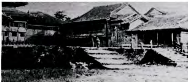
写真-2 下之御庭より御庭を見る。すでに奉神門はないが、石高欄の一部が残っている。大正末期
