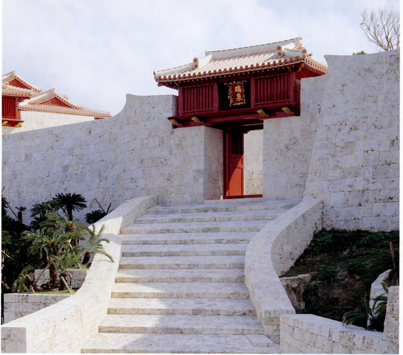
瑞泉門 手前右下に龍樋がある
