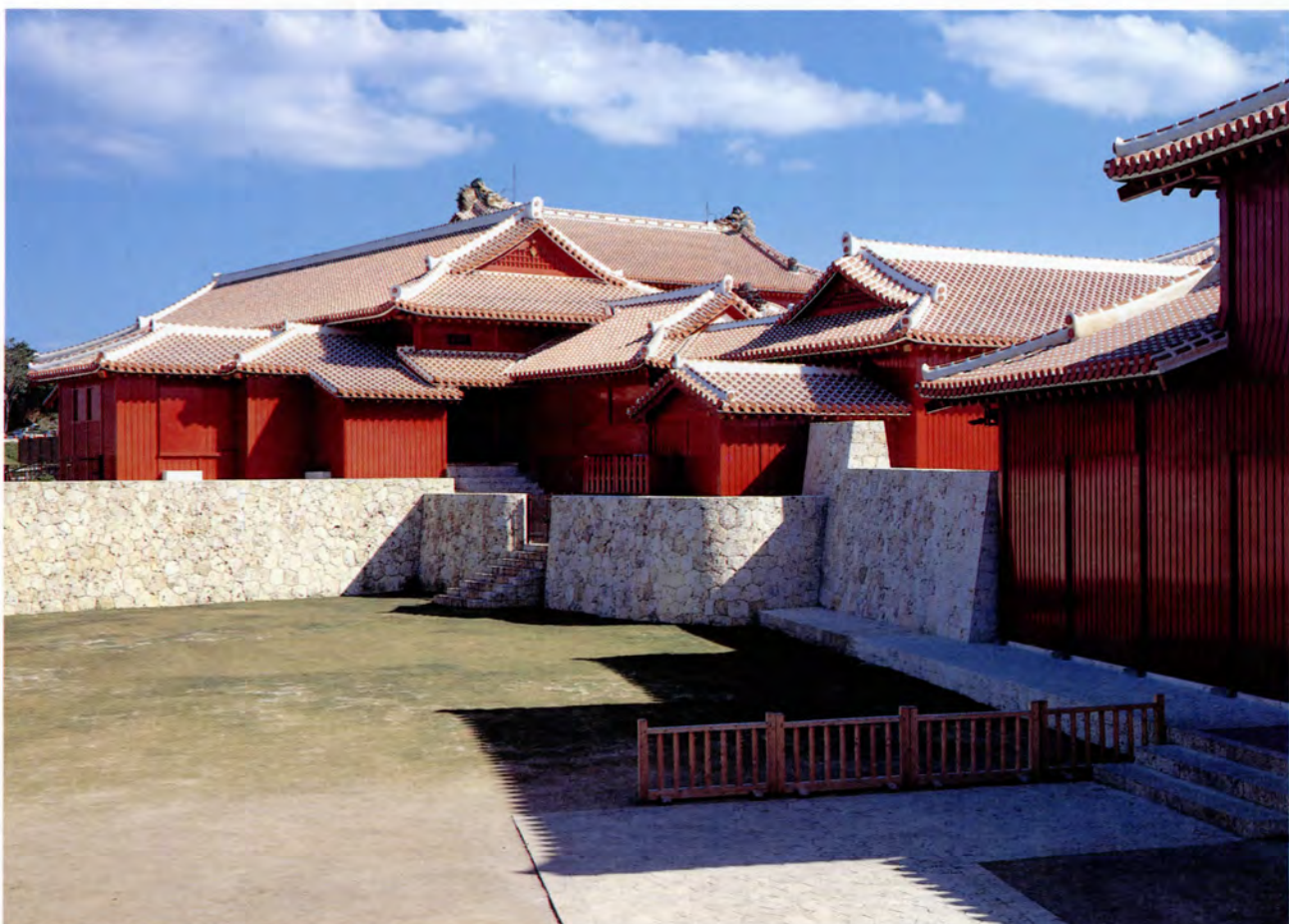
漏刻門から北殿、奉神門方向を見る
