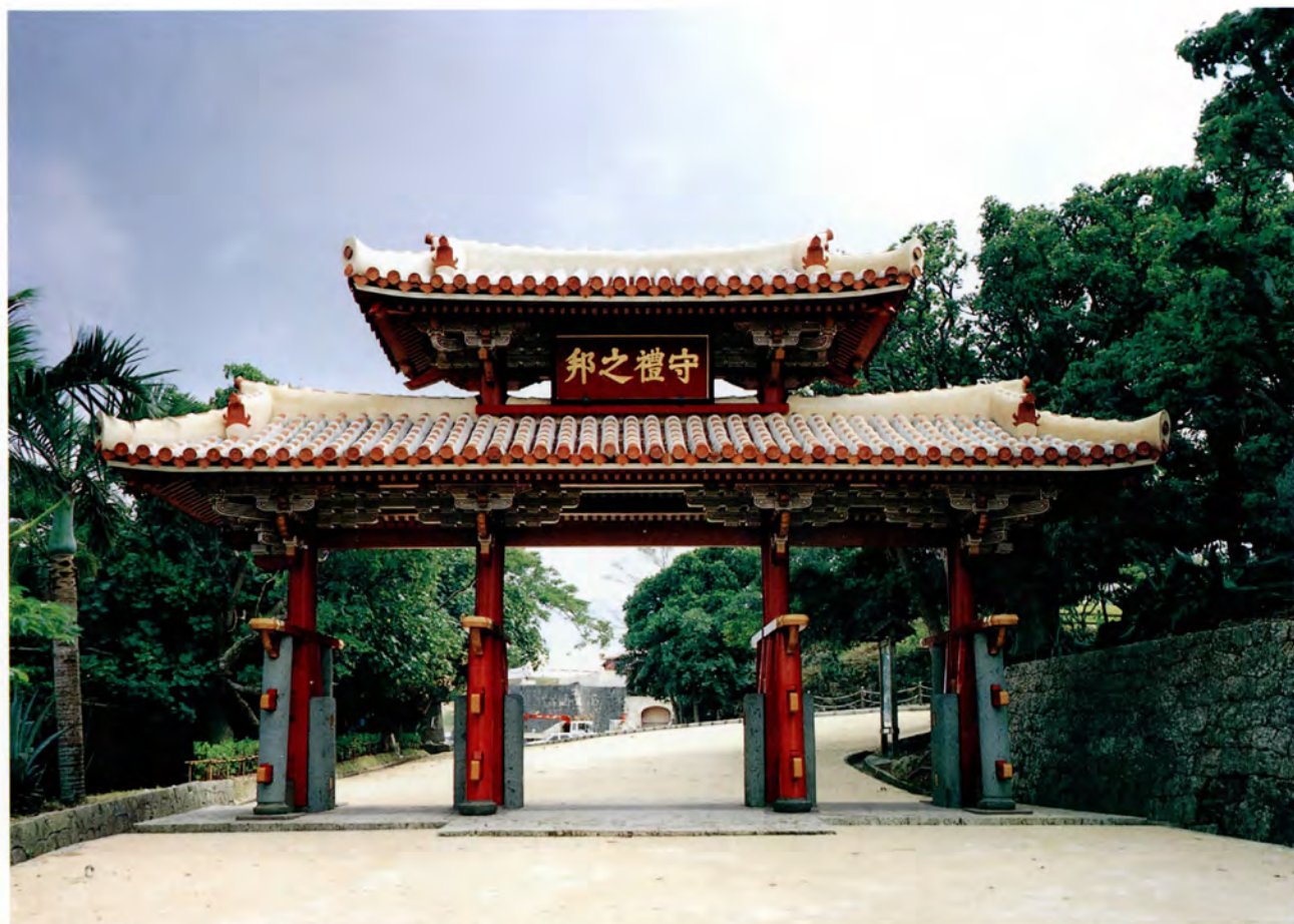
守礼門 昭和33年に復元され、平成4年に保存修理工事が行われた
