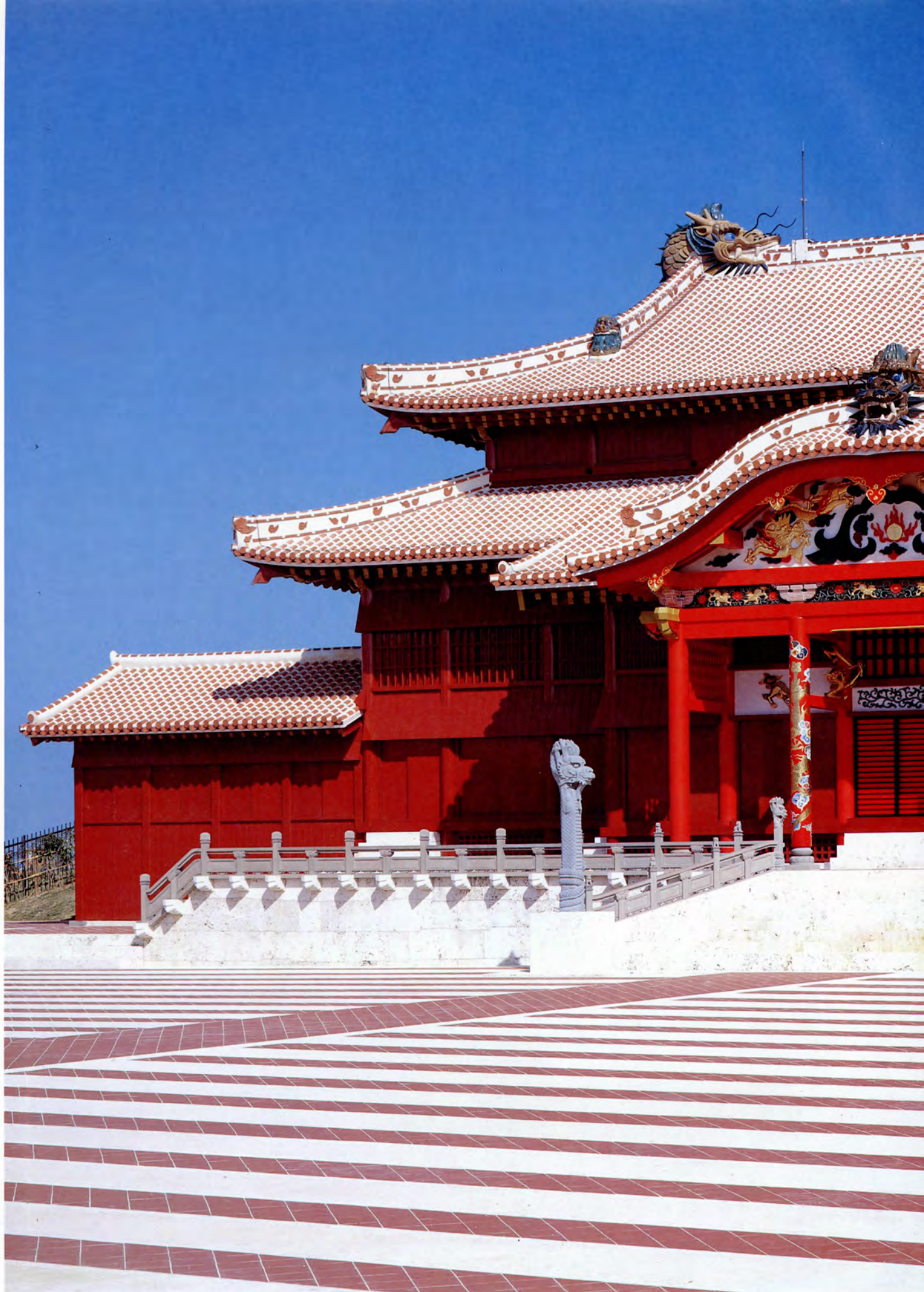
正殿全景 木造で復元された。外観は二重屋根で内部は三階建てとなっている
