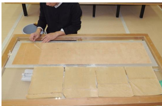
Fig. 40 肌裏紙の除去作業
