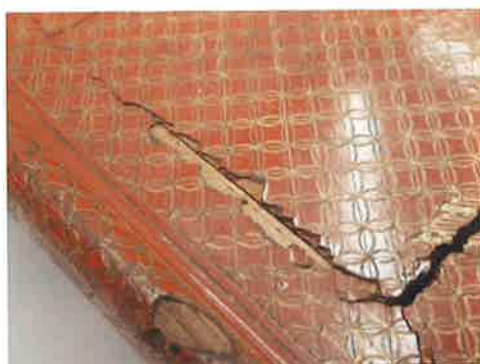
亀裂、塗膜剥離
