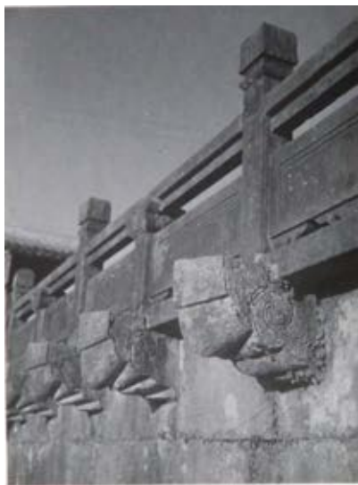
首里城正殿 基壇石勾欄（北側）
