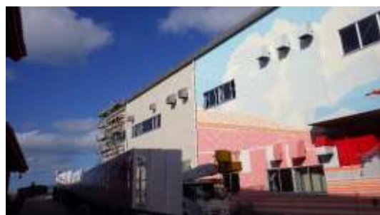
奉神門付近から見る木材倉庫の西側
