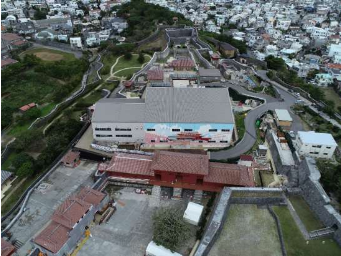
※空から見た首里城復元現場の様子
