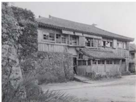
写真1 二階御殿御内原側（北面）
